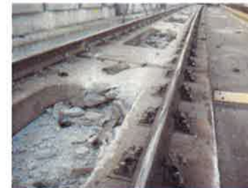
熊本～熊本総合車両所間
