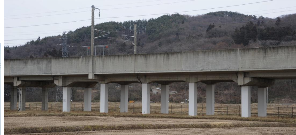
鋼板巻立(鳥石谷地区)
