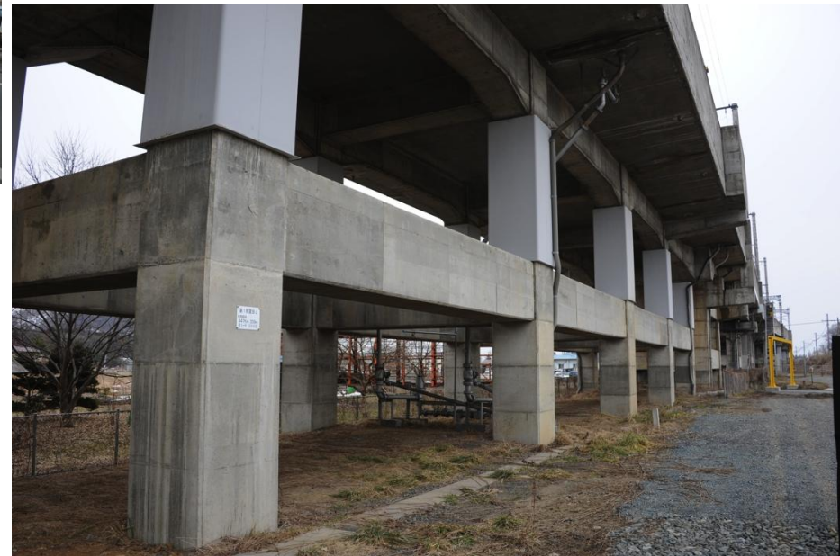
二層ラーメン上部柱の鋼板巻立(北上地区)
