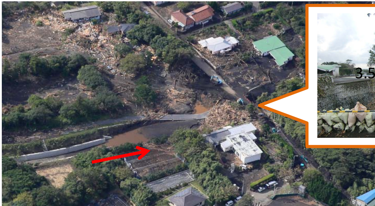
堆積工の一つ下流の橋
