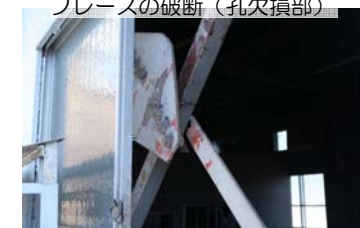
ブレースの破断（孔欠損部）
