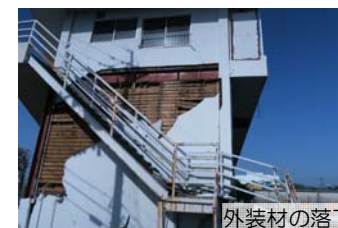
外装材の落下
