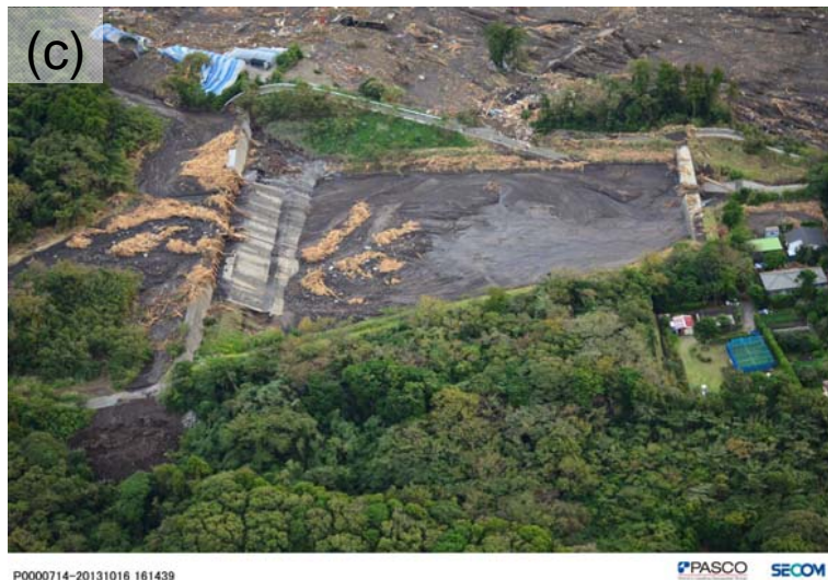
図6 堆積した流木の調査(a)元町橋周辺(b)元町橋(c)大金沢本川堆積工(d)海岸 ※(a),(c)はパスコ様より、(b)は東京都大島支庁様より御提供
