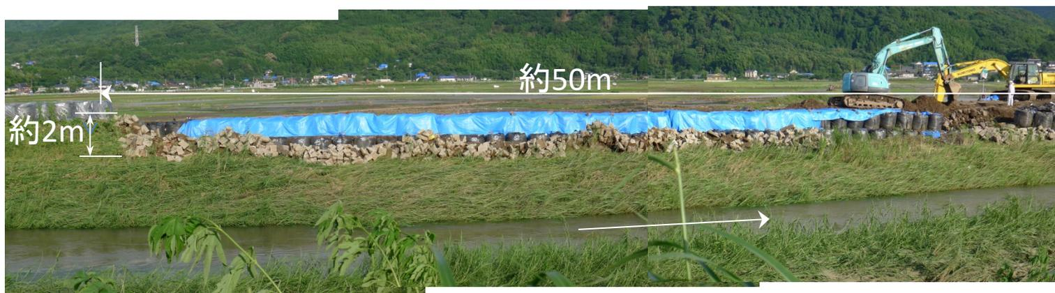
熊本県土木部は6月21日の破堤に対し徹夜の復旧工事(6月23日17時)
