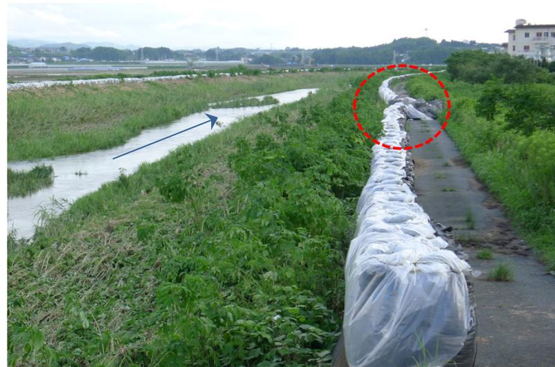
破堤部より約40m下流の右岸では高さ1mの土のうが転倒
