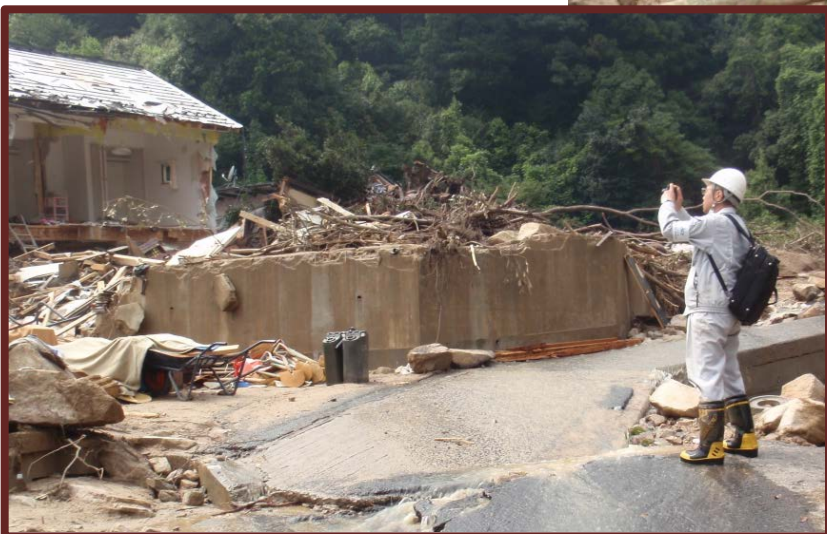
⑥緑井7丁目。土石流が住宅を直撃し、住宅を全壊している。住宅地から約100 m上流に治山堰堤があり、土石流はこの堰堤を乗り越えて流下している。土石流下流の住宅地には典型的な真砂が厚く堆積していた。
