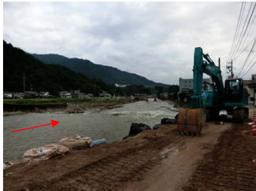
根谷川護岸破損箇所
