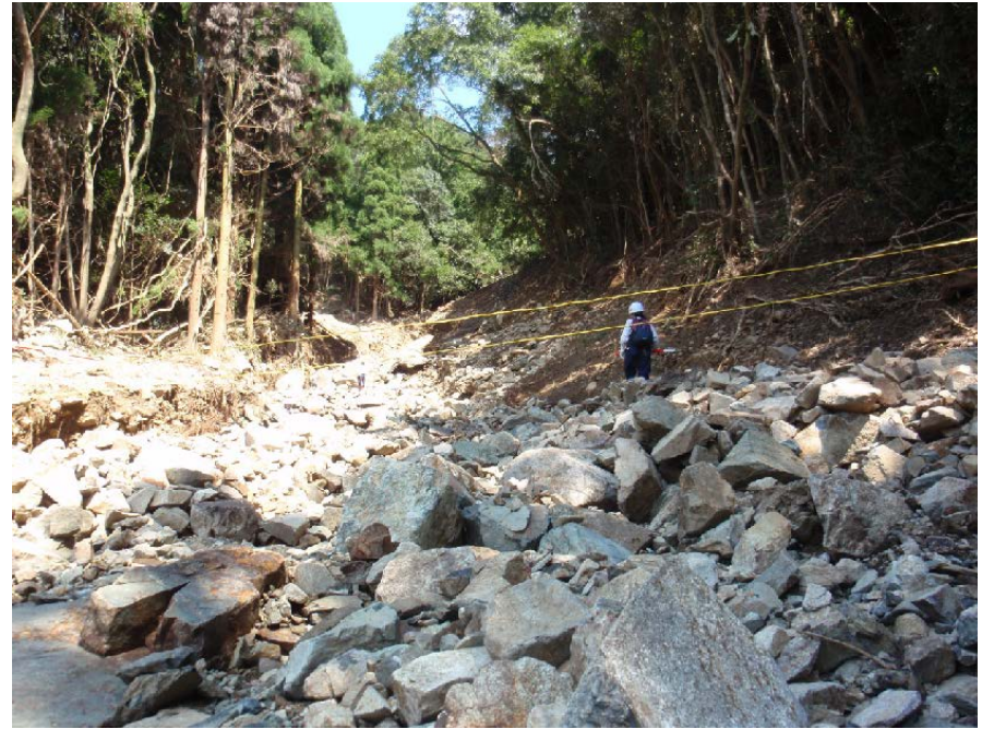
治山ダム付近から上流を望む
