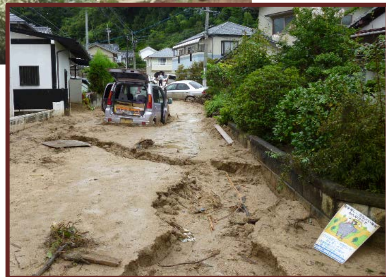
⑥緑井7丁目。土石流が住宅を直撃し、住宅を全壊している。住宅地から約100 m上流に治山堰堤があり、土石流はこの堰堤を乗り越えて流下している。土石流下流の住宅地には典型的な真砂が厚く堆積していた。
