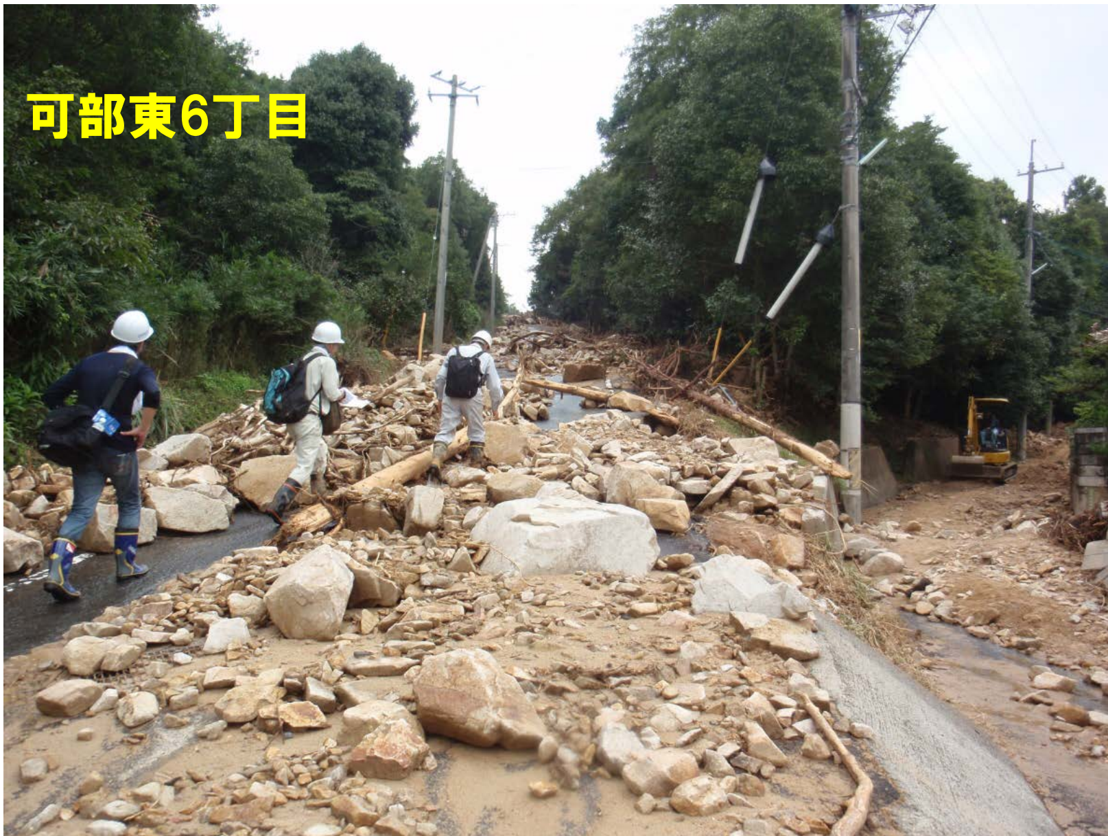
②パットゴルフ場方面から道路沿いに土石流が流下 (花崗岩, 真砂)
