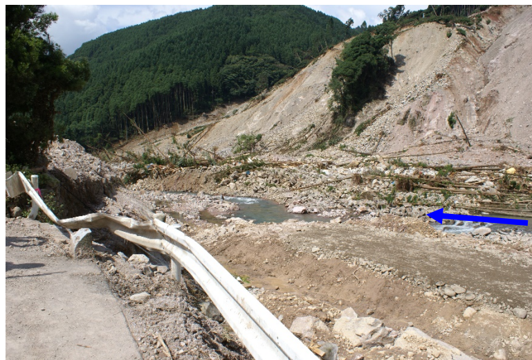
天然ダム堤体上流端
