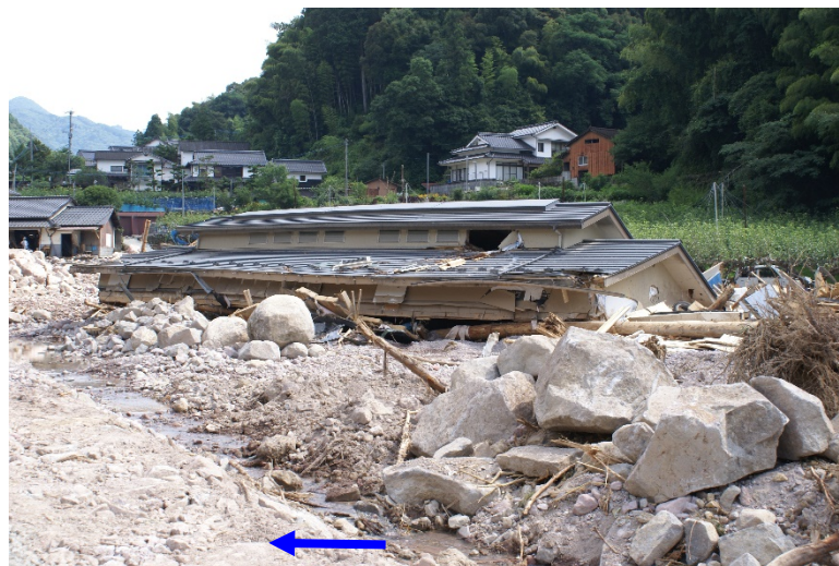
天然ダム堤体下流:家屋の倒壊.
