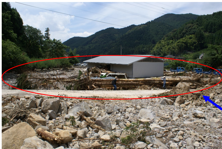
天然ダム堤体下流:長さ22.3mの流木. ほぼ立木のままの状態.
