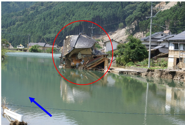
ダム湖右岸側(上流側から): 家屋 の半壊
