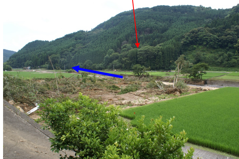
崩壊斜面下の小野川への流出状況
