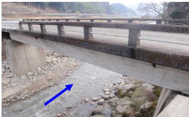
被災前の西川内橋(2013年撮影)
