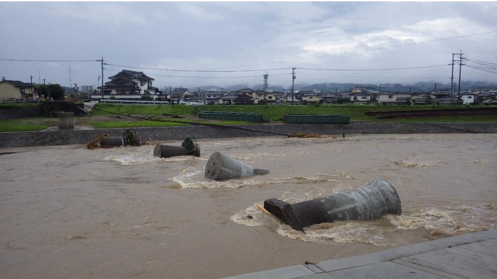
右岸側の橋脚と他の三つの橋脚の長さが異なり、倒壊の形態も違うと考えられる。
