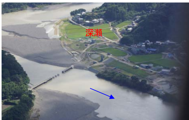
写真 7.1 那賀川 16.2k の中央橋損傷と内岸土砂堆積 (右: 国交省提供へり画像)
