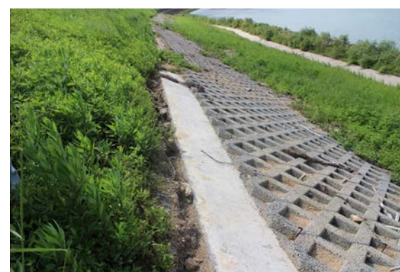
写真 7.2 縦断的に H.W.L.を上回った那賀川 13.6k 右岸の堤防損傷 (右: 国交省提供へり画像)
