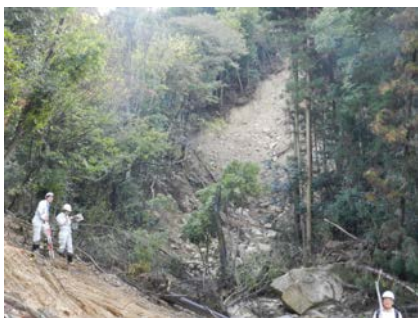
(a) 上流の斜面が崩落・土石流の発生
