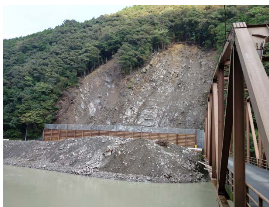
図 11.18 平鍋地区の上流斜面崩壊による道路閉塞
