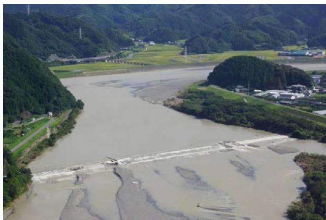
写真 7.3 那賀川 13.0k 南岸堰の被災状況 (国交省提供へり画像)
