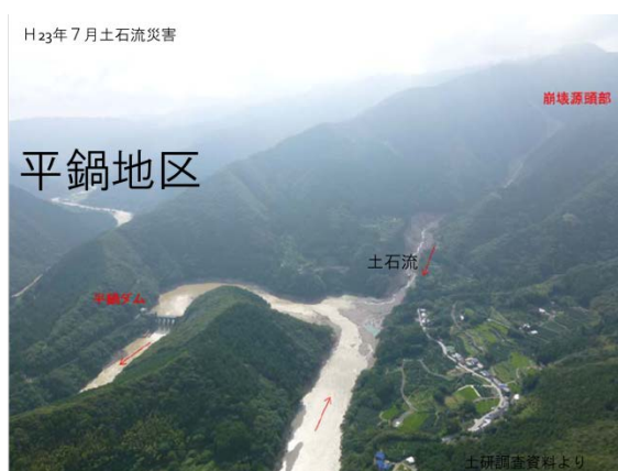
図 11.16 平鍋地区の土石流
