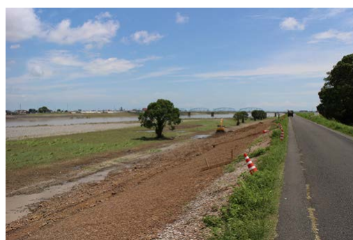
洪水後の状況 (H26年8月)
