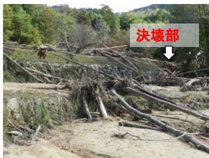
(e) 堤体決壊および越流による流出
