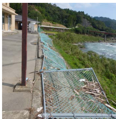
写真 9.2 浸水により破損したフェンス
