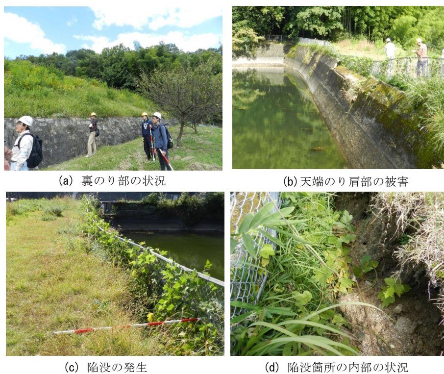
図 15.15 浄円寺池の被災状況
