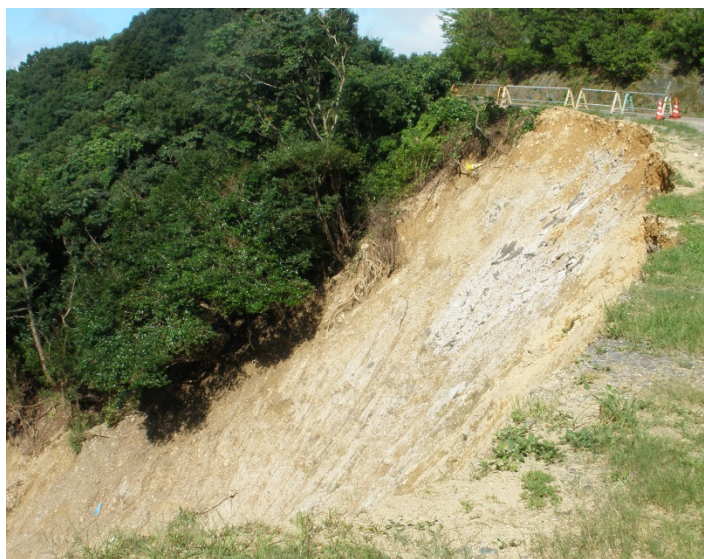
図 4.3 阿南市椿泊の盛土崩壊
