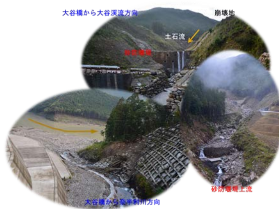
図 11.17 平鍋地区の土石流対策用砂防堰堤
