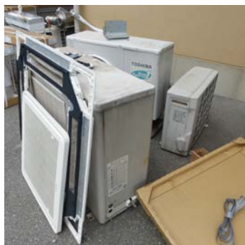
写真 9.3 浸水により被害を受けたエアコン室外機
