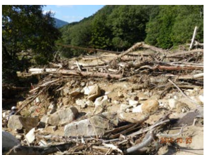
(c) ため池への土砂の流入。土砂をくい止める
