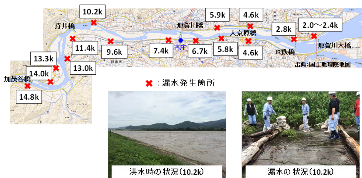
図7.1 那賀川2014年8月洪水による漏水発生状況
