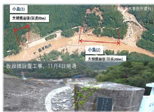
図 11.15 小島地区の斜面崩壊
