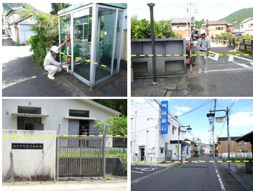
図 10.12 窪川地区における浸水被害調査状況
