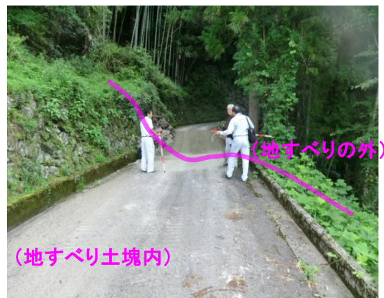
図 11.12 伸縮計②の下方の亀裂
