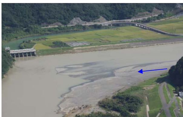
写真 7.2 縦断的に H.W.L.を上回った那賀川 13.6k 右岸の堤防損傷 (右: 国交省提供へり画像)
