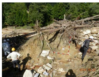
(d) 流入土砂による衝撃と越流により決壊
