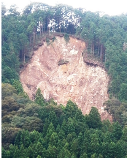
図 4.2 海陽町上若松の斜面崩壊（滑落崖）
