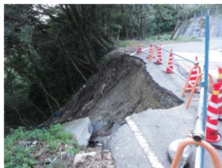
写真 9.9 施設周辺の道路崩落現場
