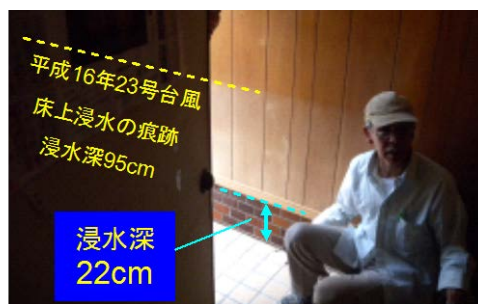
写真 13.4 浸水した上物部地区
