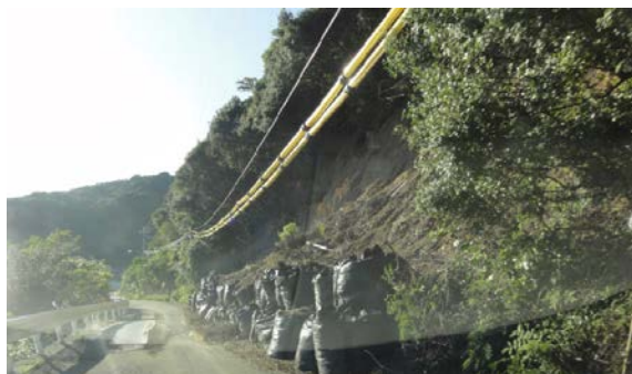
写真 9.8 斜面崩壊により通行止めとなった県道
