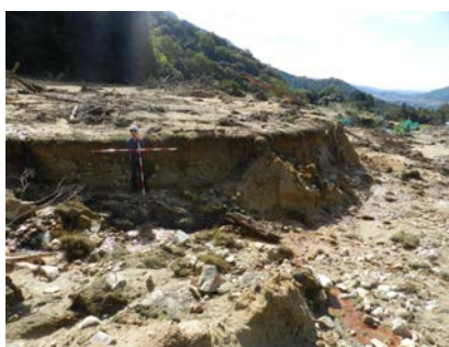
(f) 堤体決壊および越流による流出
