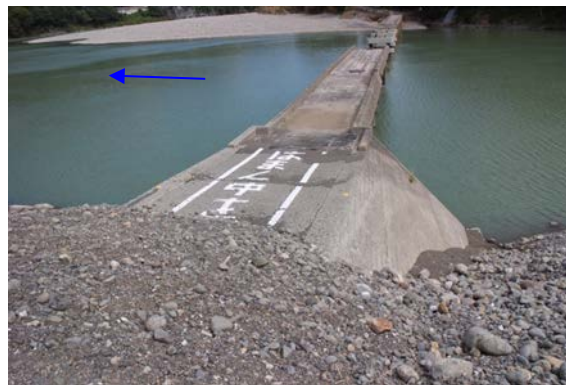
写真 7.1 那賀川 16.2k の中央橋損傷と内岸土砂堆積 (右: 国交省提供へり画像)
