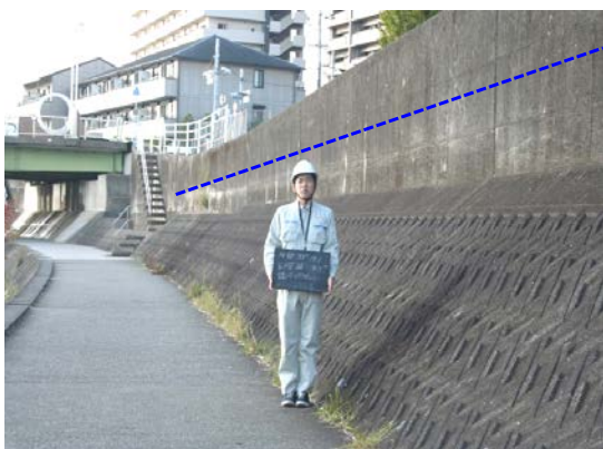
図 10.7 4.2km 右岸付近の痕跡水位
