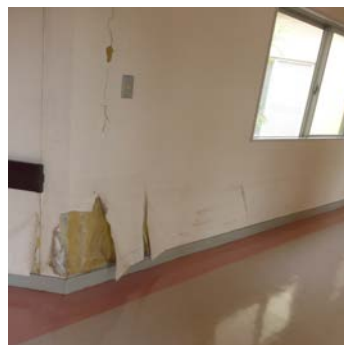
写真 9.4 浸水により被害を受けた内装
