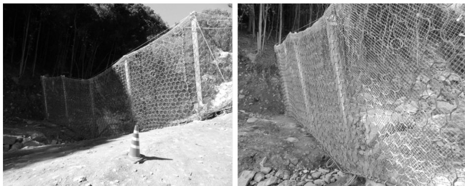
図 15.16 八木三丁目の溪流に設けられた応急対策工（リングネット工）
