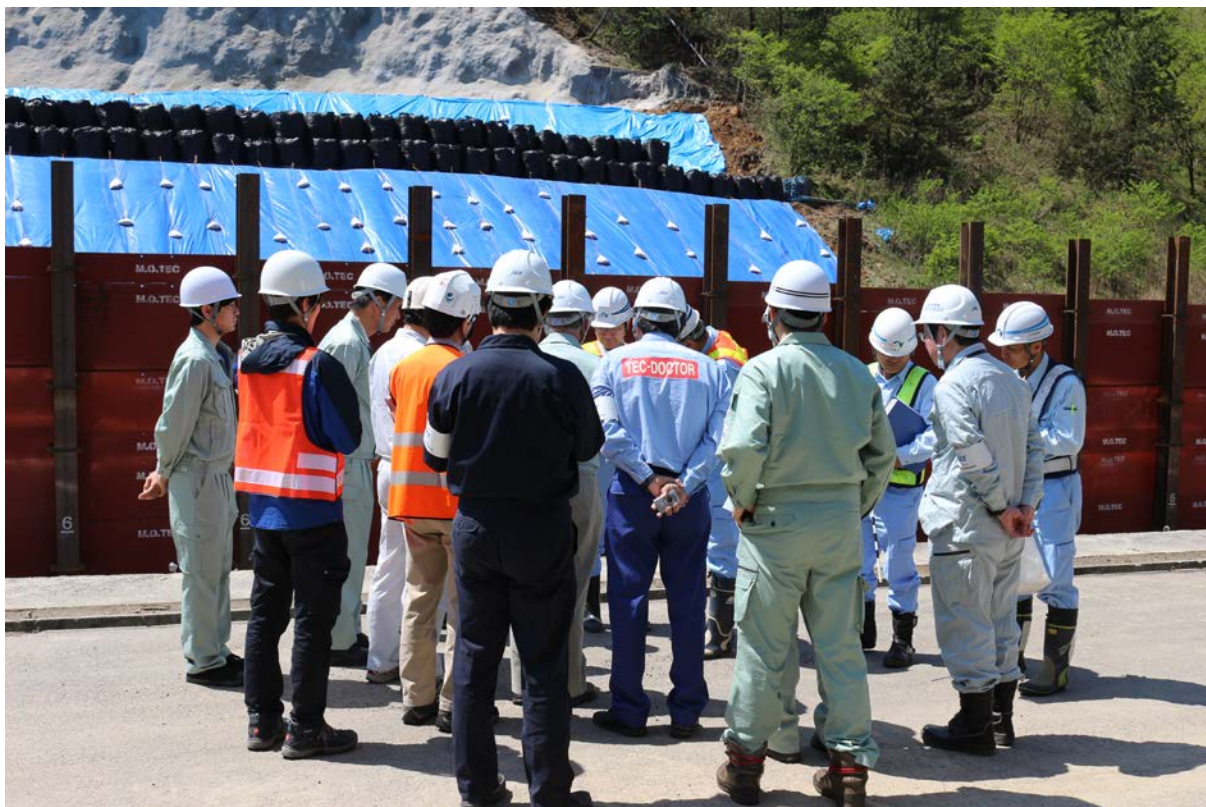
大分道 94KP 切土崩壊現場付近（2016 年 4 月 29 日）
