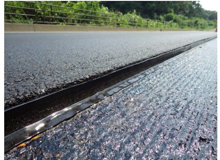
L型の目地材の設置例
