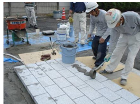
3. 目地モルタル散布
