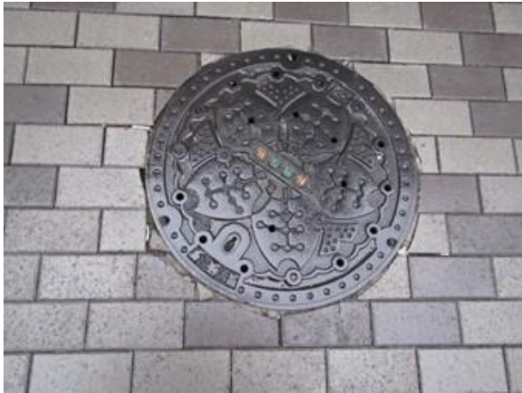
写真上左 丸形路面施設周りの好ましくない納まり例 写真上右 角形路面施設周りの好ましくない納まり例
