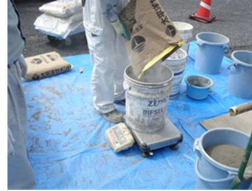
砂・水・セメントの計量(砂の含水比から事前に加水量を決める)
