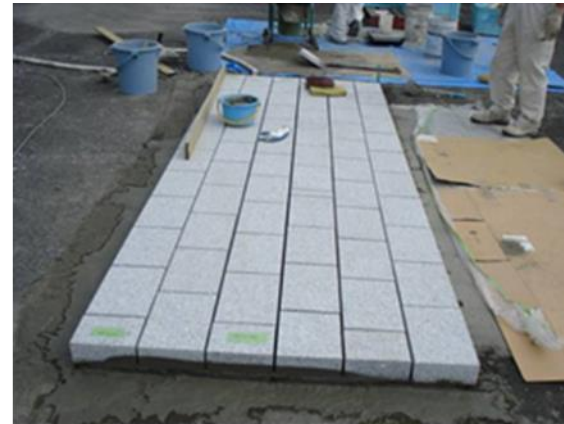
11. 自然石ブロック敷設完了
