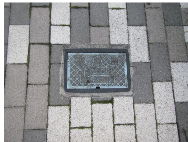
写真上左 小さな丸形路面 施設周りの好まし くない納まり例 写真上右 小さな角型路面施 設周りの好まし くない納まり例
