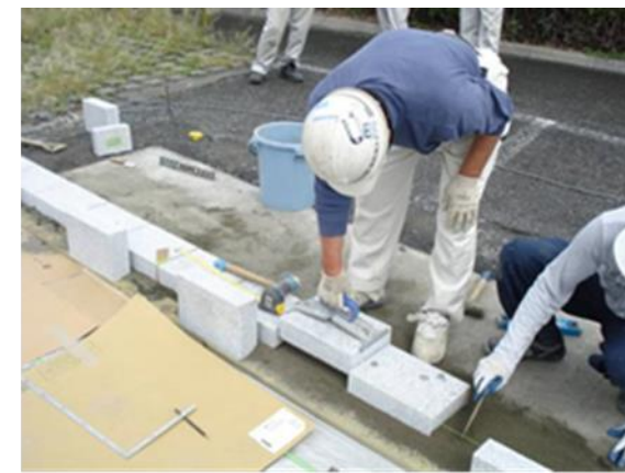
6. レベル調整後に自然石ブロックを抜取る
