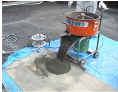
砂 → 水 → セメントの順でミキサに投入、練り混ぜ
