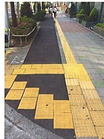
写真 7.4 景観が損なわれている例2
