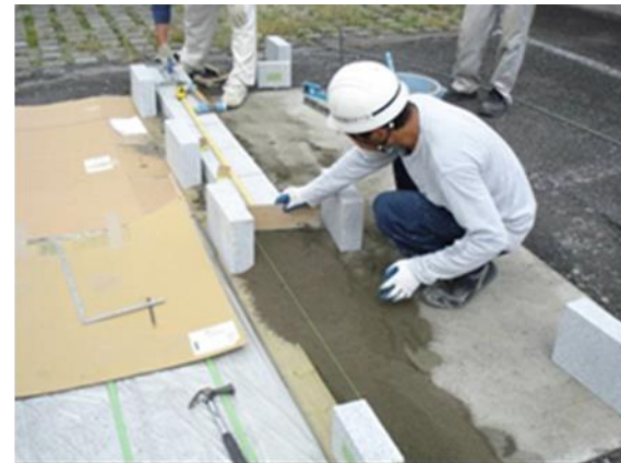
3. 敷モルタル平坦仕上げ
