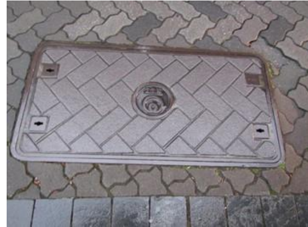
写真上左 丸形路面施設周りの好ましくない納まり例 写真上右 角形路面施設周りの好ましくない納まり例
