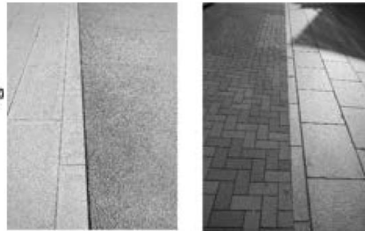
写真-1.11 端部の処理状況例
