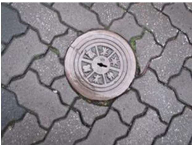
写真上左 小さな丸形路面 施設周りの好まし くない納まり例 写真上右 小さな角型路面施 設周りの好まし くない納まり例
