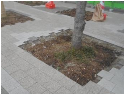
比較的取りやすい部分からブロックを外す(写真では植栽周辺)
