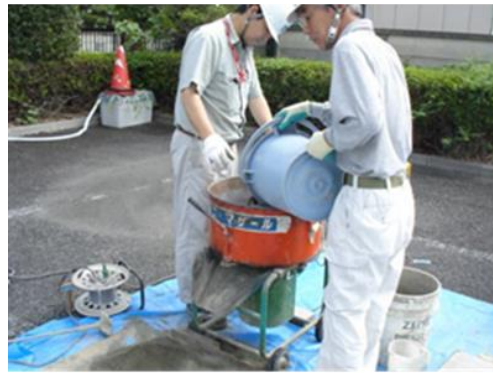
砂 → 水 → セメントの順でミキサに投入、練り混ぜ
