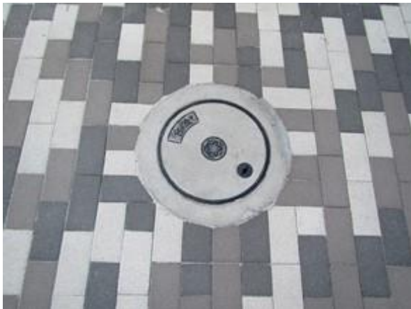
写真下左 写真上左の好ましい納まり例 写真下右 写真上右の好ましい納まり例
