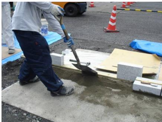
2. 敷モルタル敷き均し
