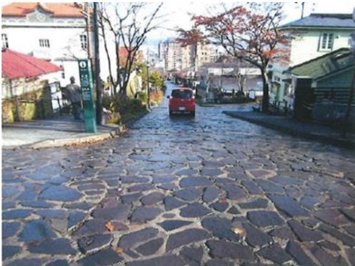
写真-3.14 破損なく健全な状態
