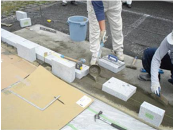
7. 敷モルタルの上に セメントペースト散布
