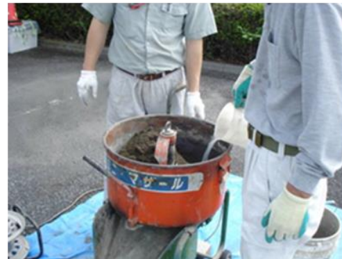
砂 → 水 → セメントの順でミキサに投入、練り混ぜ
