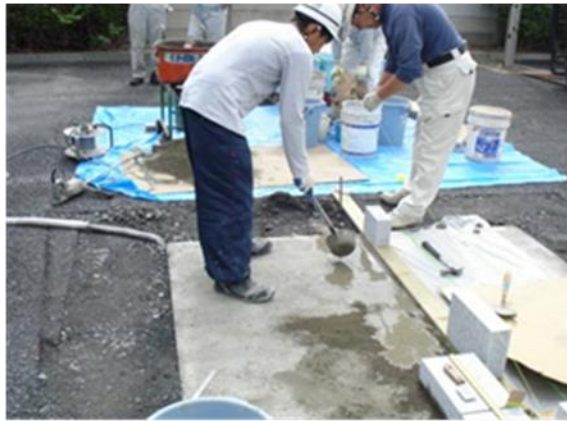
1. セメントペースト散布(Co版上)
