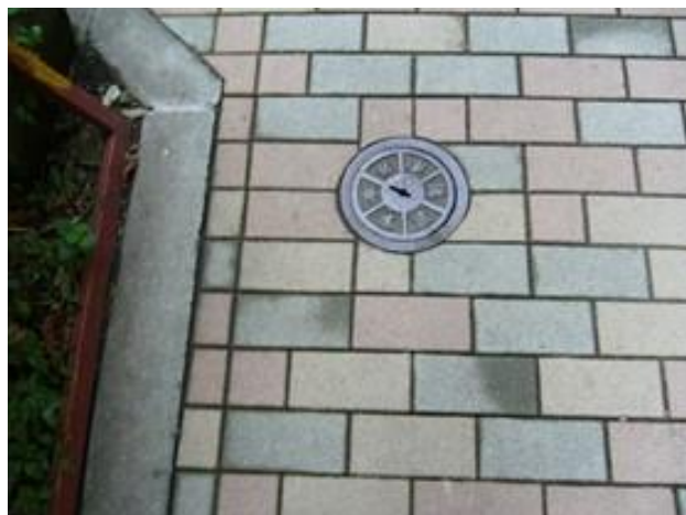
写真下左 丸形路面施設 周りの好まし い納り例 写真下右 角型路面施設 周りの好まし い納り例
