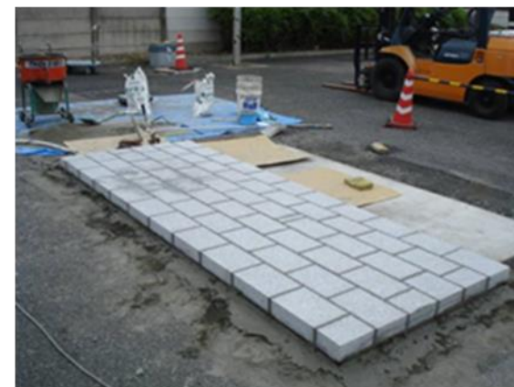
6. 自然石ブロック施工完了
