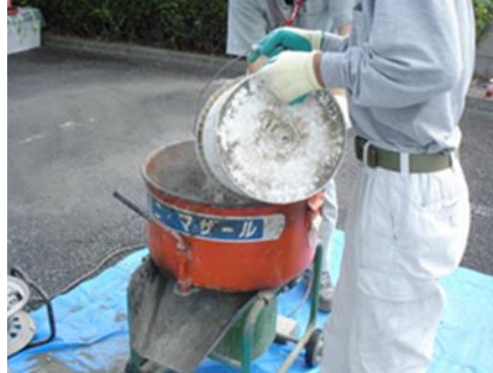
砂 → 水 → セメントの順でミキサに投入、練り混ぜ
