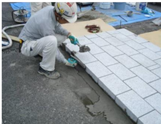
1. 舗装端部をモルタル止め
