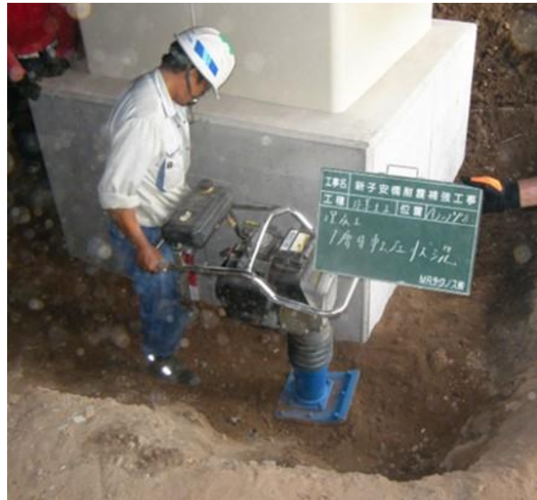
写真右 ランマによる構造物周りの締固め
