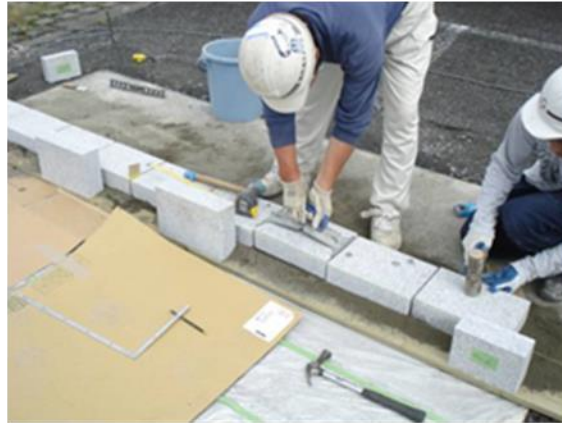
8. 自然石ブロックを再敷設
