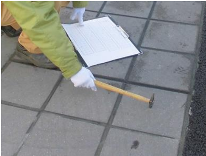
写真-3.12 打音による空隙調査
