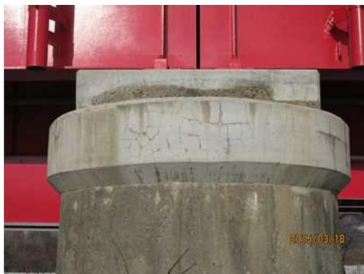
図 5.3.3 橋脚張出部の補修後の再劣化の事例
