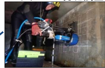
コンクリートの劣化調査
