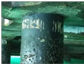
鋼材の目視調査
