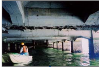
コンクリートの目視調査
