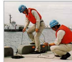
鋼材の電位測定（電気防食）
