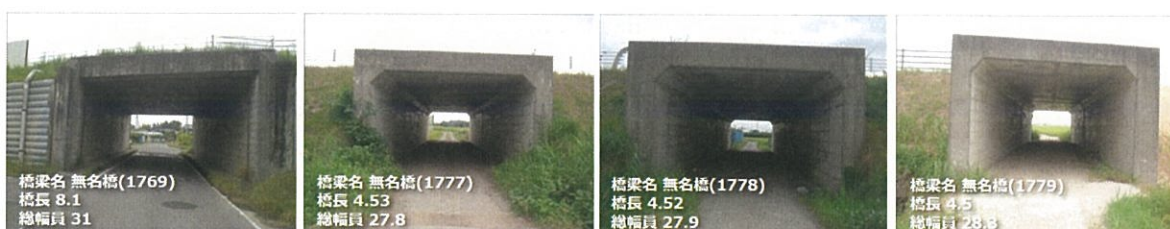
図 4-2.3 江南区モデル事業対象橋梁 4 橋
