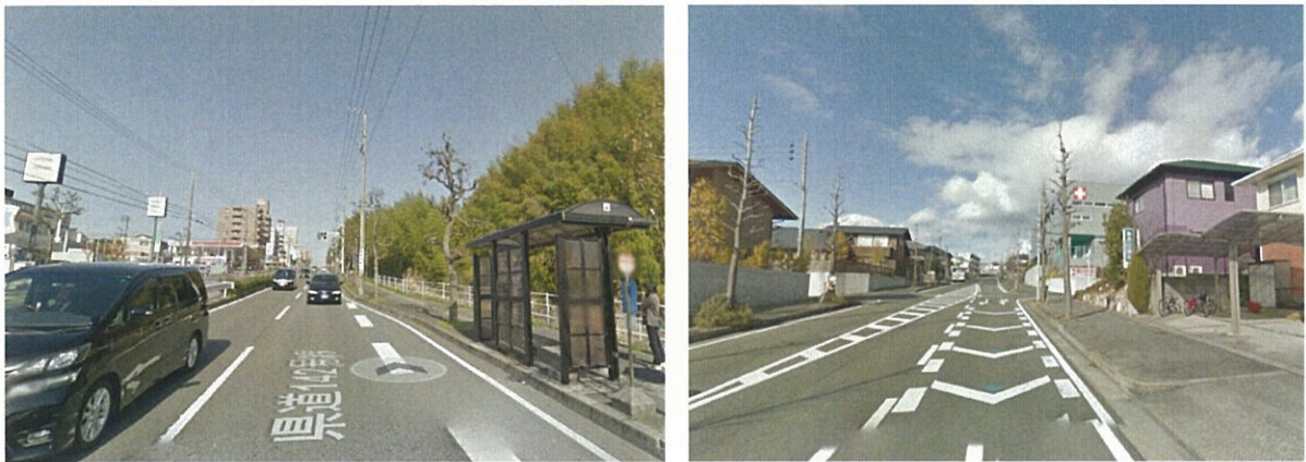
図 3-3-6 大山田地域における地区幹線道路の一例
