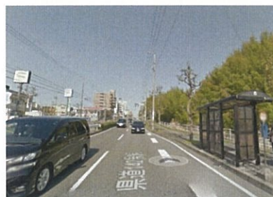
【地区幹線道路（県道142号線）】
