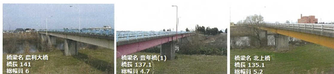
図 4-2.5 秋葉区モデル事業対象橋梁 3 橋
