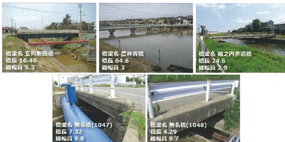
図 4-2.1 西区モデル事業対象橋梁5橋
