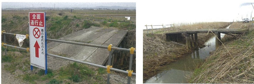
図 6-3.3 管理区分 3 の小規模橋梁（無名橋 490）
