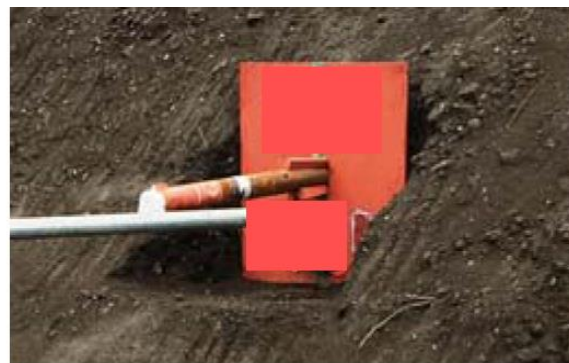
図-2 小径羽根付き鋼管（外径 100mm 程度） 写真-1 受圧板（矩形 300~800mm 程度）
