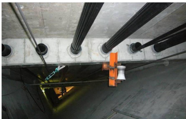
写真-2 桁内挿入設備 (中央径間)
