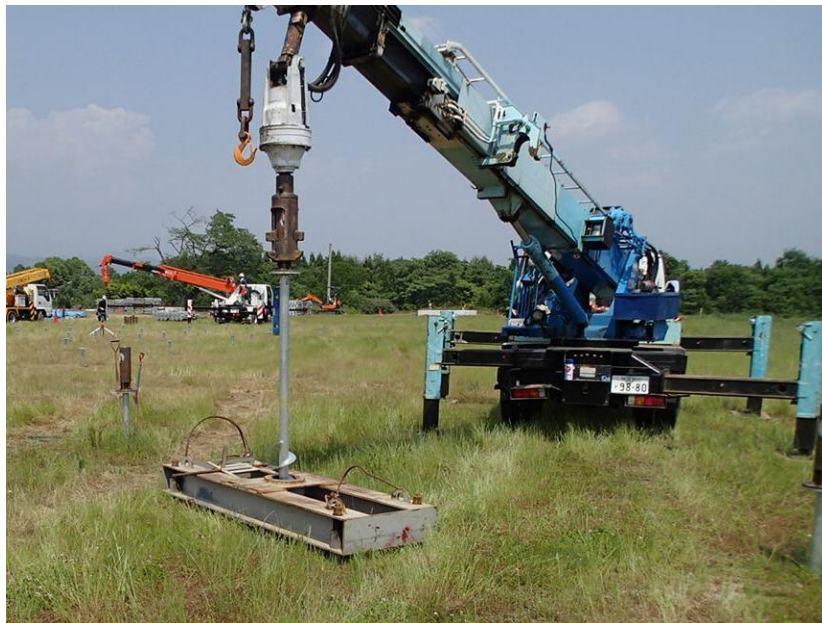
写真－2 太陽光架台基礎工事例
