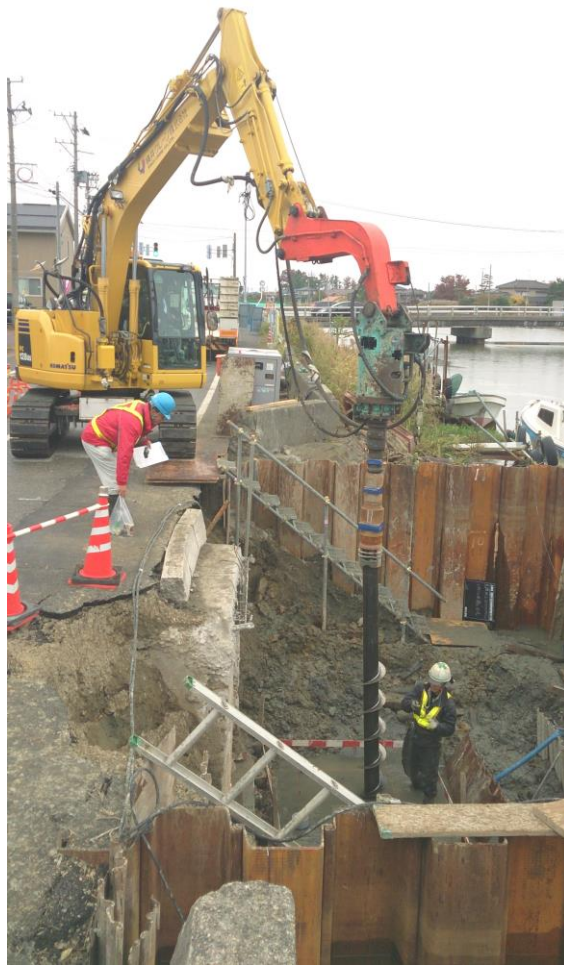
写真－1 農業土木構造物（樋門）基礎工事例
