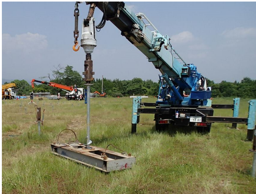
写真－２ 太陽光架台基礎工事例
