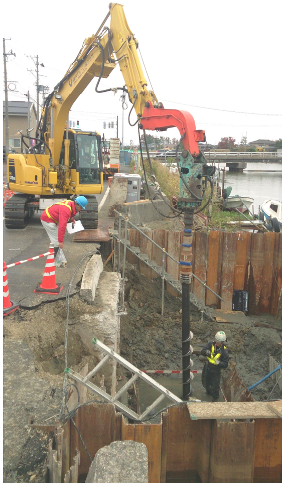
写真－１ 農業土木構造物（樋門）基礎工事例
