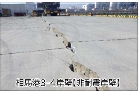
⇒非耐震の岸壁では、大きなひび割れ、段差が発生
