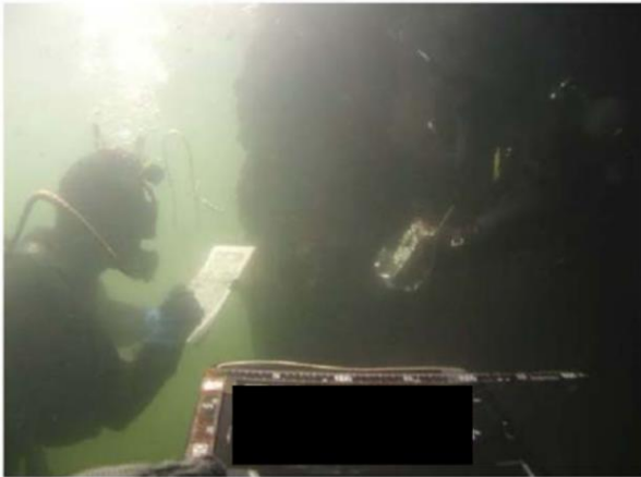
図 鋼矢板の潜水目視状況
