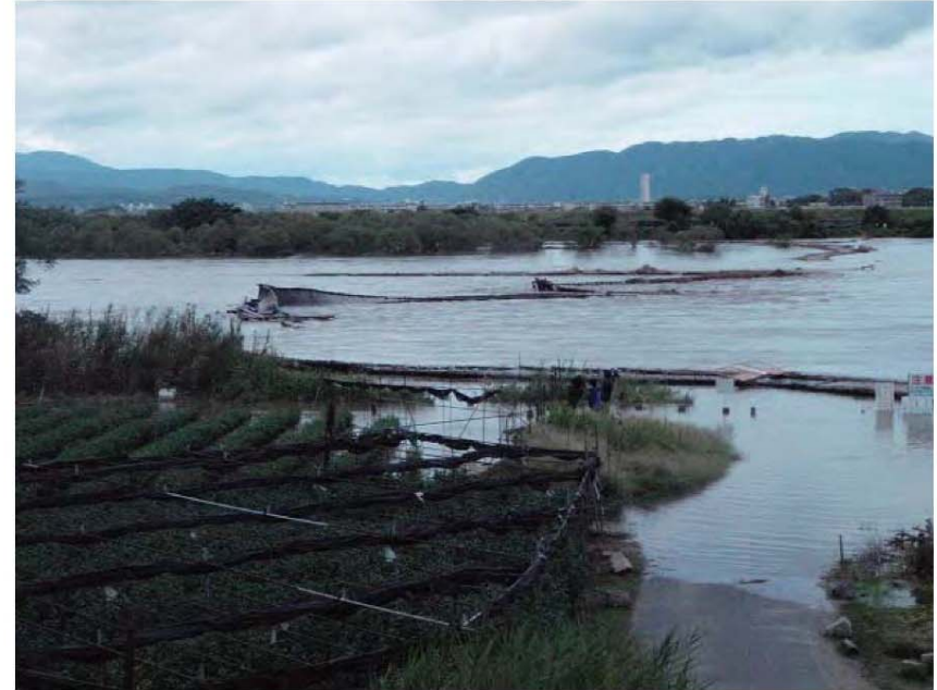
橋板が流出し始めている上津屋橋
