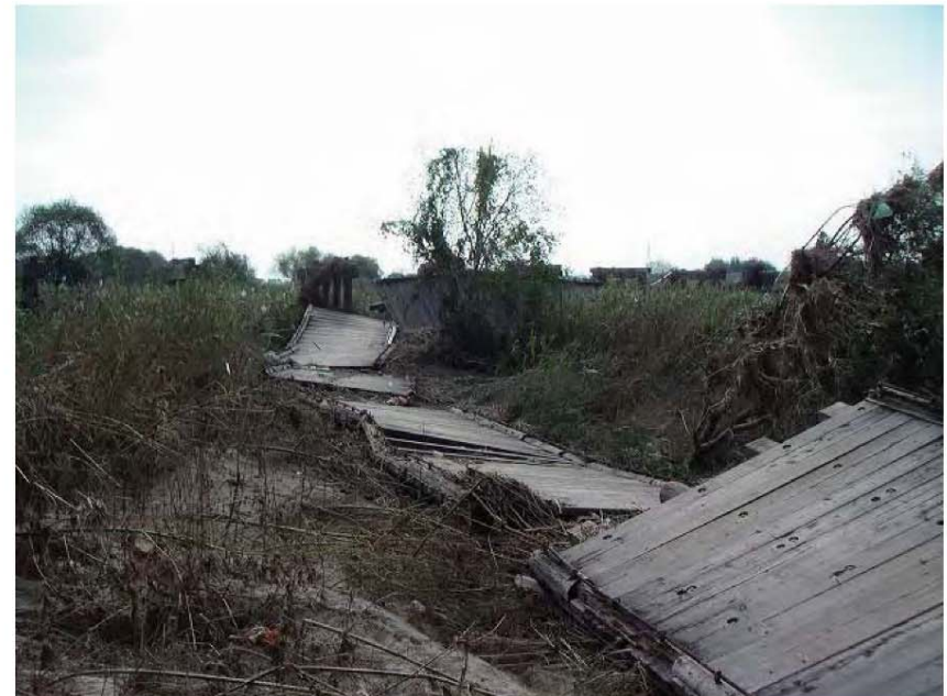
横たわる橋板のユニット
