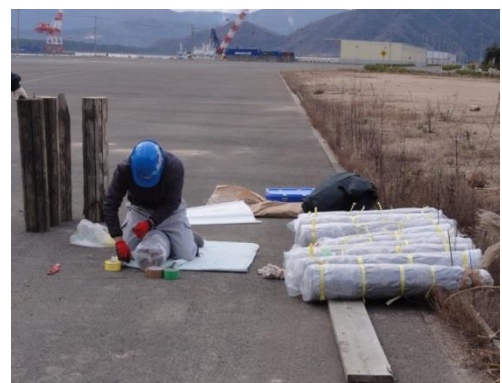
写真-解8 木材の切断とラッピング
