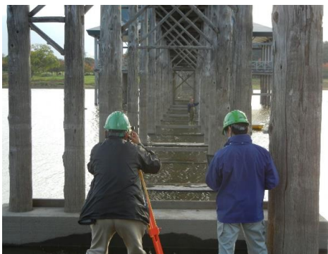
写真-4 橋脚基礎の測量
