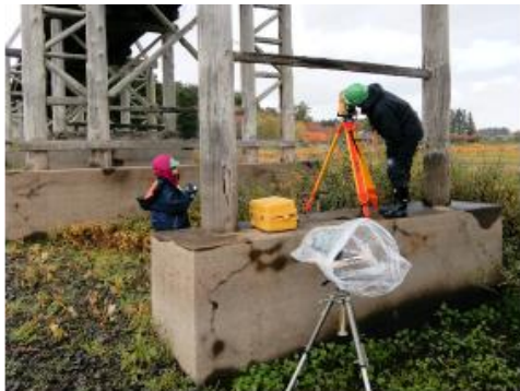
写真-3 橋脚の水平角測量
