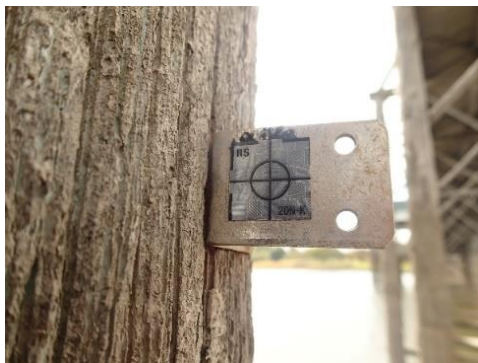
写真-2 橋脚ターゲット
