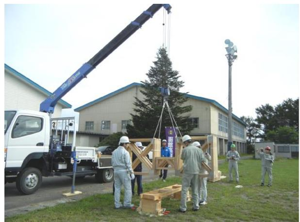
写真-5 折り畳み橋を架設台へ設置
