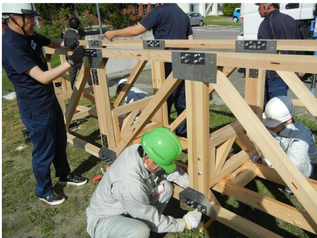
写真-7 連結板の取り付け
