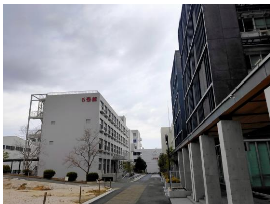
写真-4 設置位置と周囲の状況 (写真は南側から)
