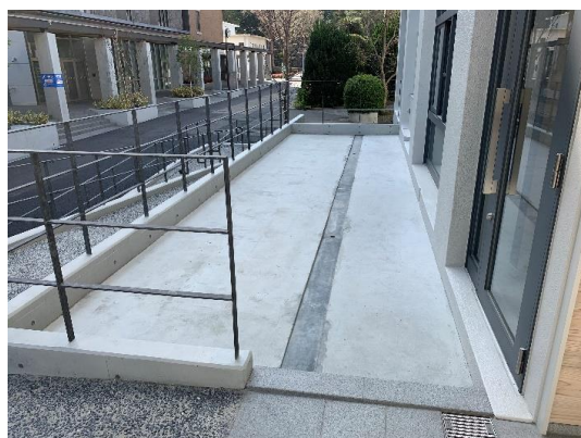
写真-5 デッキ版を設置したスペース
