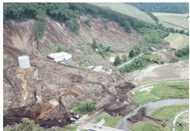
写真-1 平成30年北海道胆振東部地震による被害
