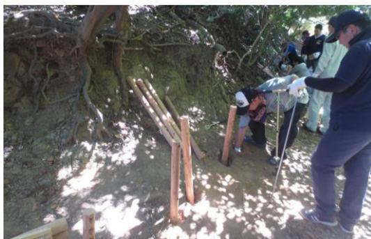
写真-9 礫が多い箇所の穴掘りの様子
