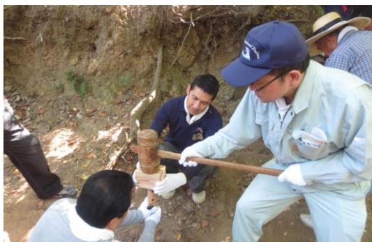
写真-10 杭材の打ち込みの様子
