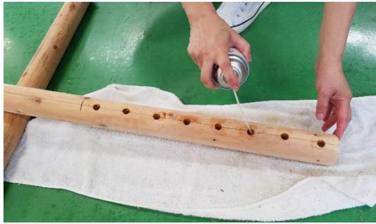
写真-7 杭材の加工と防腐剤噴霧
