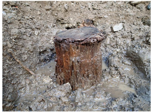
(b) フーチング撤去後
