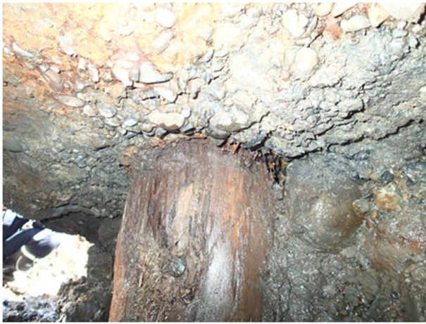
(a) フーチング撤去前
