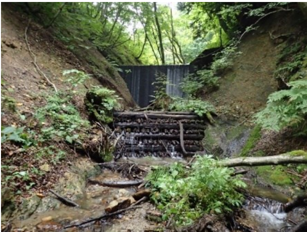
写真-3 3号木堰堤（1957年施工）
