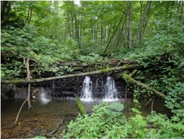
写真-1 1号木堰堤（1958年施工）
