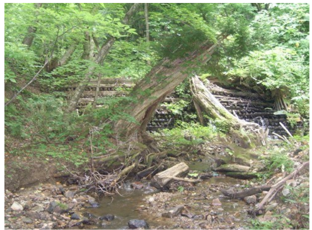
写真-4 4号木堰堤（1954年施工）
