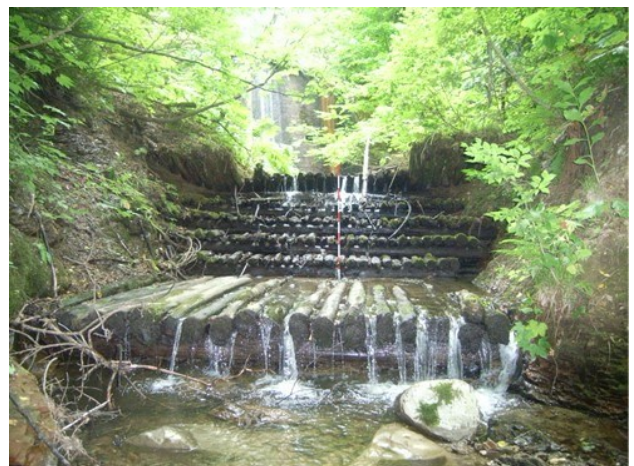
写真-6 6号木堰堤（1953年施工）
