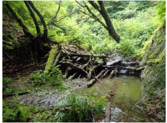
写真-2 2号木堰堤（1916年施工）
