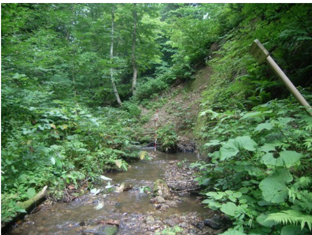
写真-5 5号木堰堤（1916年施工）
