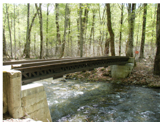
図-1 登山道に架けられたプレストレス木箱桁橋
