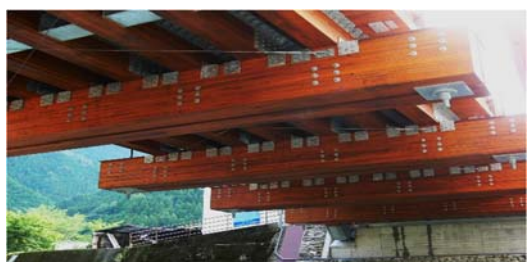
写真-2 対象橋梁の床組構造
