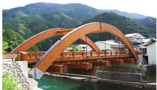
写真-1 梶原橋の全景
