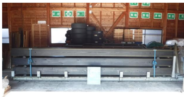
写真-21 防腐剤注入後の主桁材
