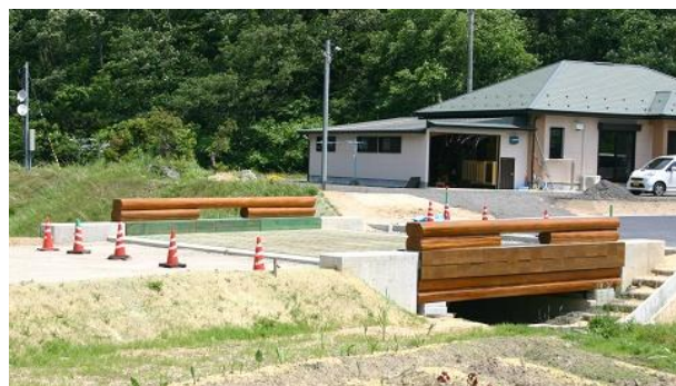
写真-1 架設中の金深木橋（2005 年）
