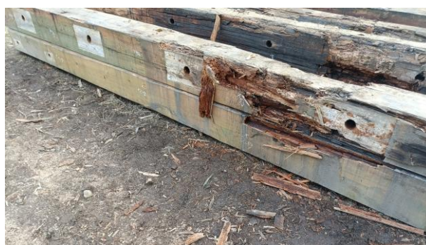
写真-19 主桁材の側面の例
