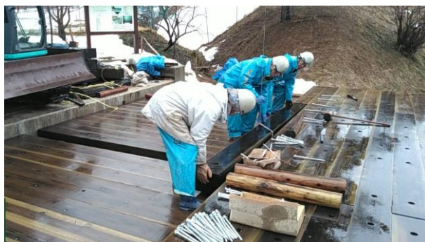
写真-25 床版材の設置
