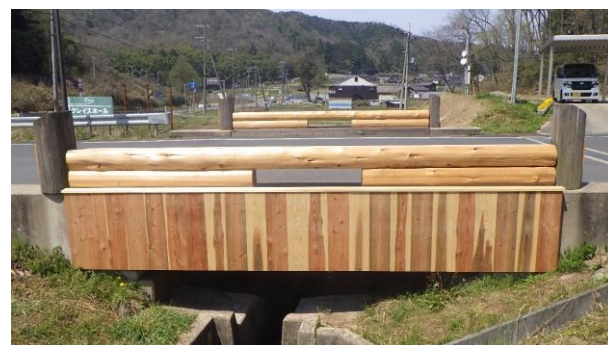
写真-11 改修後の状況（2016 年）
