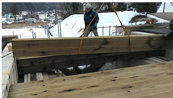
写真-23 主桁材の設置
