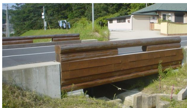
写真-7 駒止材と桁保護材（2006年）
