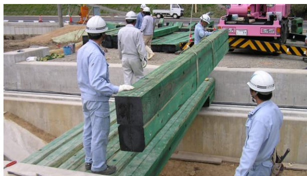
写真-8 桁の設置の状況
