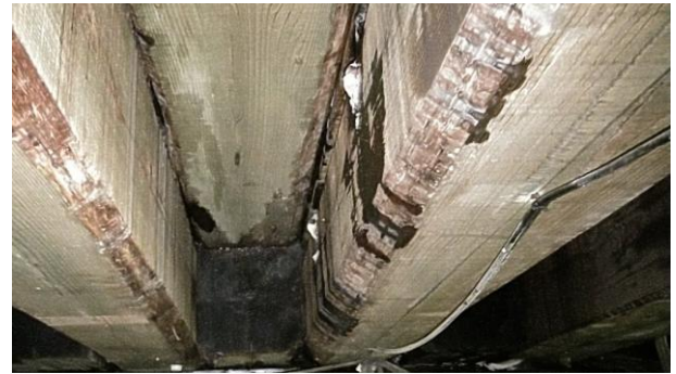
写真-15 桁下の様子（2024 年）
