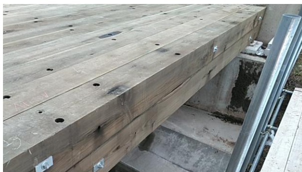
写真-24 設置された主桁材
