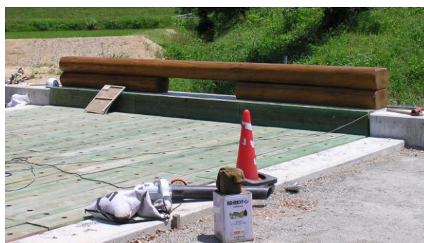
写真-6 床版材の敷設の状況
