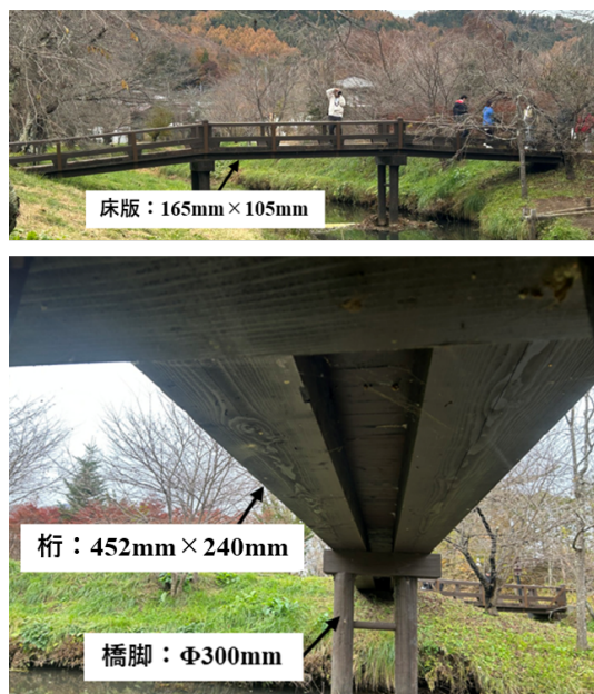
図-1 八海橋 1 号の外観
