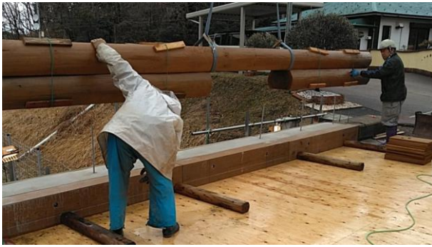
写真-26 駒止材の設置
