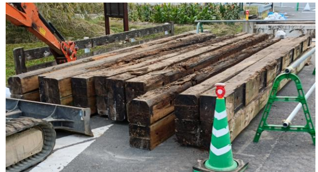
写真-16 撤去された主桁材
