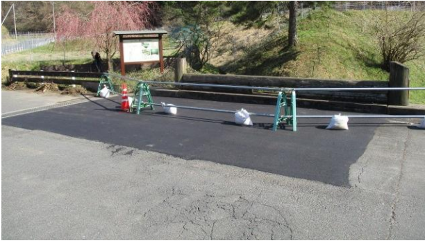
写真-12 舗装打換え時の路面（2023 年）
