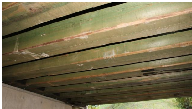
写真-5 桁下の状況（2015年）
