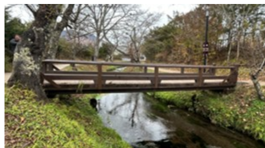
図-3 八海橋 2 号の外観
