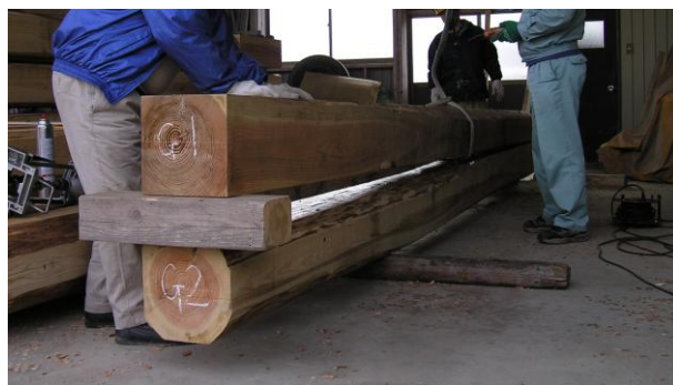
写真-4 積層桁の製作の様子
