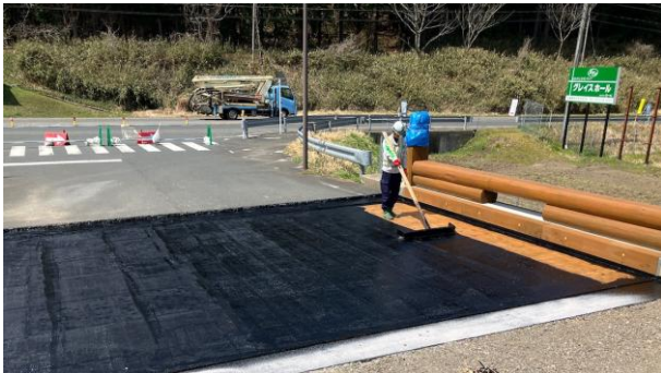
写真-27 防水層の設置
