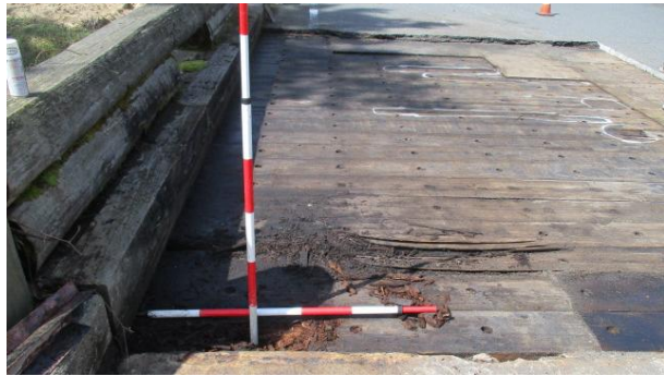
写真-13 床版材の上面の様子（2023 年）
