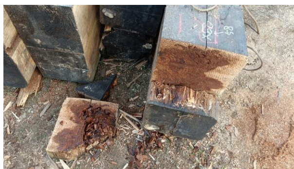
写真-18 主桁材の木口付近の例(2)
