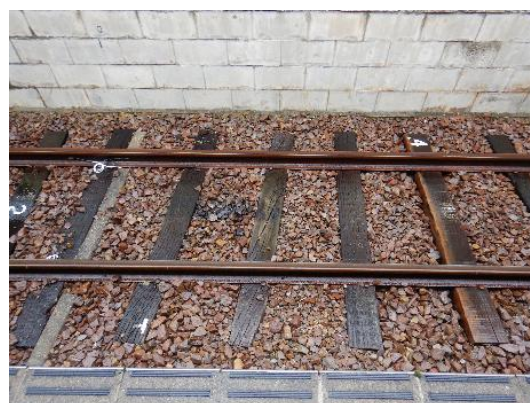
写真-1 木まくらぎの事例 (明知鉄道 恵那駅構内)
