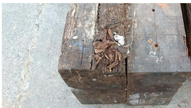
写真-17 主桁材の木口付近の例(1)
