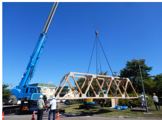
クレーン架設(2023.9)
