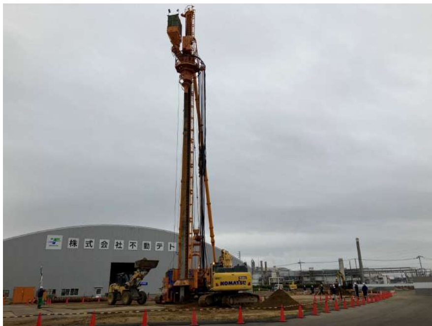
SCP工法の一つである SAVE(静的締固め砂杭)工法で施工
