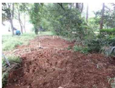
地盤の掘起こし
