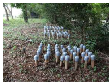
キャップの設置 (9月, 打設から3ヶ月後)
