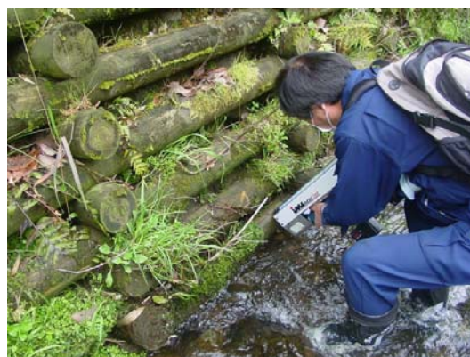
写真-6.3.2.8 穿孔抵抗試験機による計測（私市）
