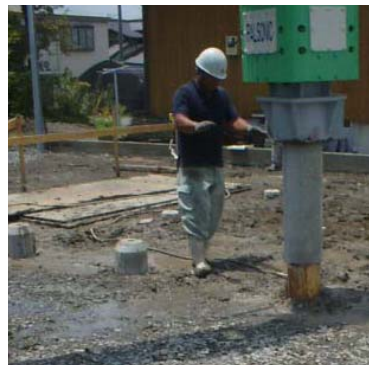
写真-7.2.4.1 トップコンクリート施工状況
