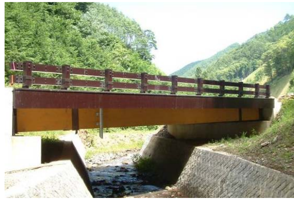
写真-5.1.8 さくら橋（長野県箕輪町）
