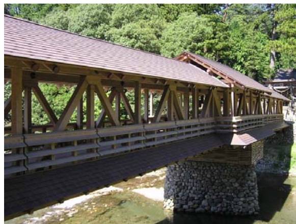
写真-2.2.14 御幸橋 (高知県)
