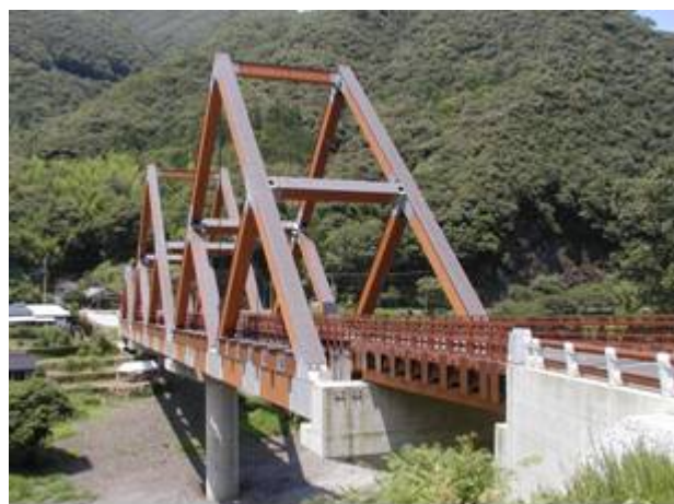
写真-4.5.2 集成材を利用した大規模木質構造の例 かりこぼうず大橋（宮崎県）
