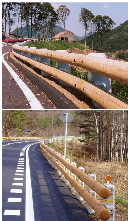
写真-8.1.2 木製防護柵設置現場 (上：宮崎県, 下：長野県)
