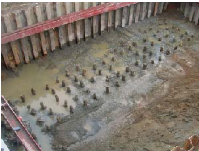
図-2.1.11 橋脚を取り除いた木杭頭部の様子 17)
