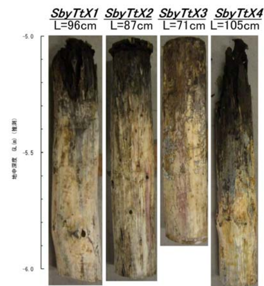
写真-7.2.1.1 杭頭付近の状況(2009.1.13.採取杭)
