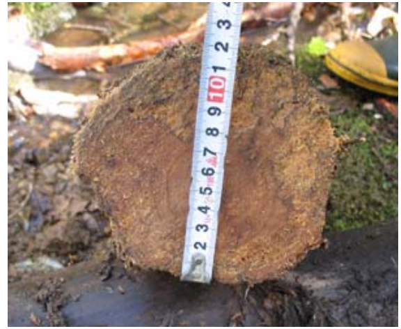
写真-6.1.4.2 部材断面状況
