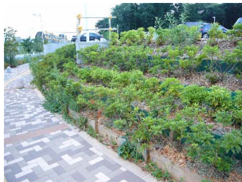
(a) のり面緑化工全景
