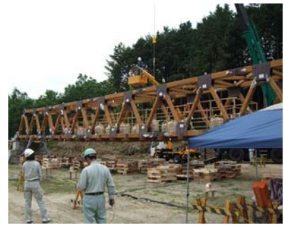
写真-5.1.11 木橋の耐荷力試験
