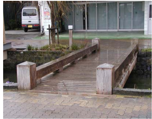
写真-2.2.10 大井手用水路の木橋（熊本県）
