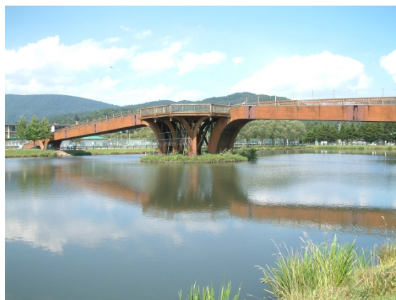
写真-5.1.2 矢ヶ崎大橋（軽井沢町）
