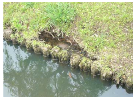
(a) 植生に覆われた水路
