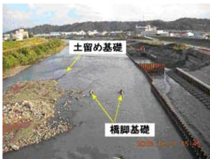
(a) 水越橋上流付近
