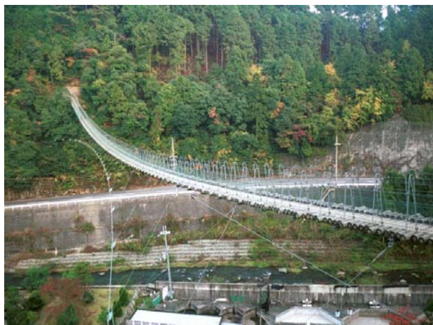
写真-2.2.17 黒滝吊橋（奈良県）
