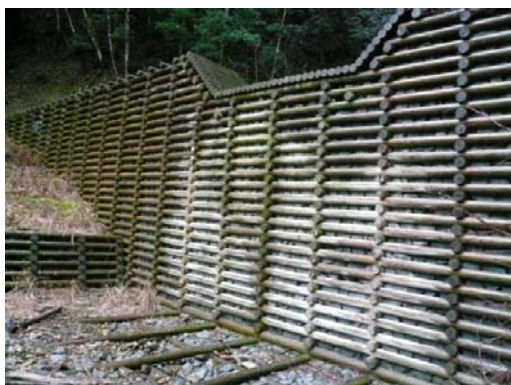
写真-6.3.2.1 校倉式木製谷止工 (奈良奥山)
