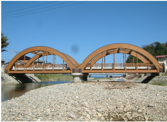
写真-5.1.7 八幡橋（新潟県村上市）
