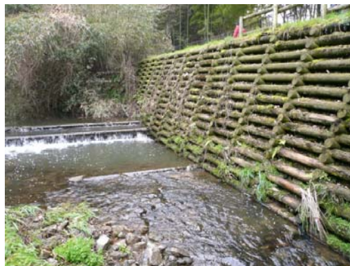
写真-6.3.2.2 校倉式木製護岸工 (私市)
