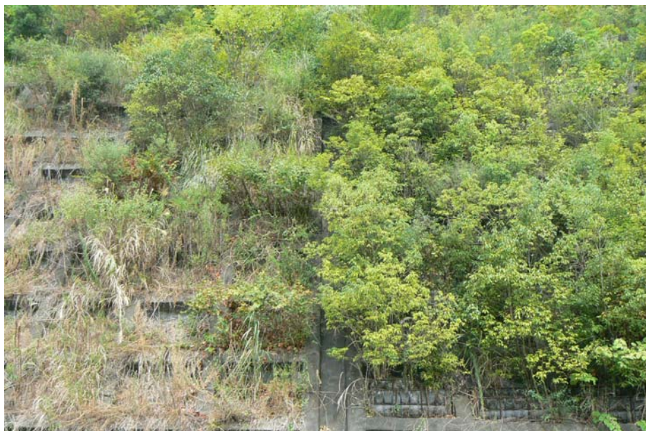
写真-8.2.2 従来の種子吹き付け緑化工法による法面（左）と本緑化工法による法面（右）の状況
