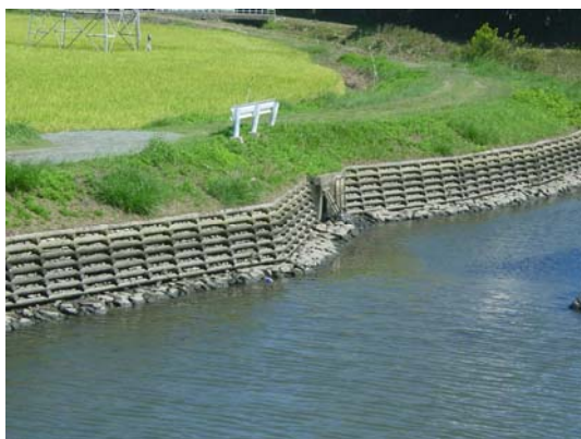
写真-6.3.2.5 校倉式木製護岸工（豊川放水路）
