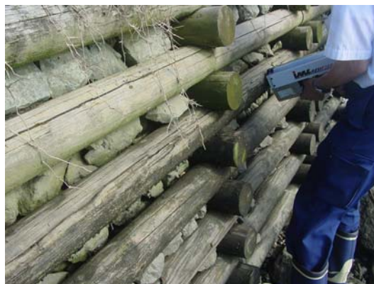
写真-6.3.2.10 穿孔抵抗試験機による計測（豊川放水路）
