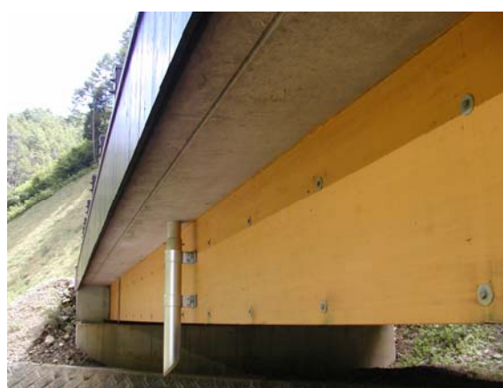
写真-2.2.20 RC床版との合成桁橋 (さくら橋／長野県)
