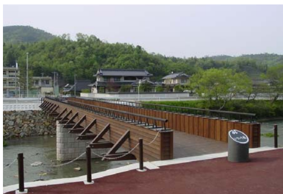
写真-5.1.5 いきいき橋（広島県尾道市）
