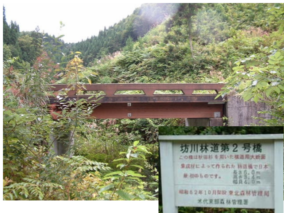
写真-5.1.1 坊川林道 2 号橋（北秋田市）
