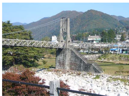
(a) 主塔部遠景
