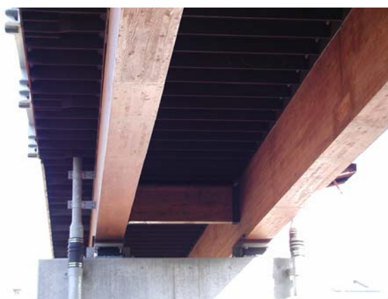
写真-2.2.19 鋼床版との合成桁橋 (八丁平つなぎ橋／北海道)
