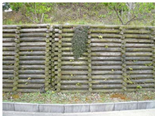
写真-6.3.2.3 校倉式木製土留工 (根来山)
