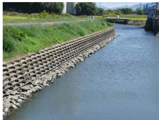
写真-6.3.2.6 校倉式木製護岸工（豊川放水路）
