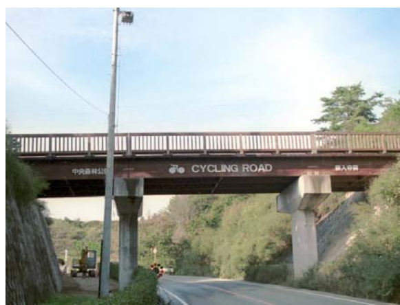
写真-2.2.6 新しい木橋の例 (善入寺橋／広島県)
