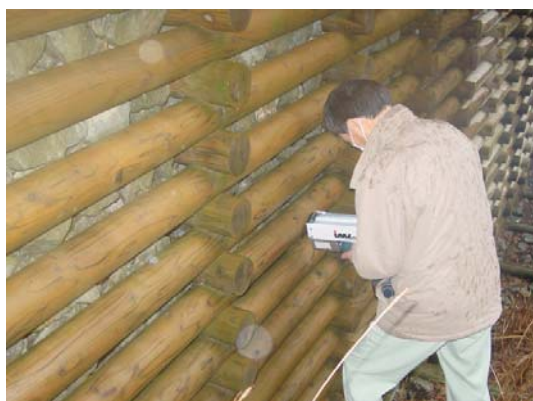
写真-6.3.2.7 穿孔抵抗試験機による計測（奈良奥山）
