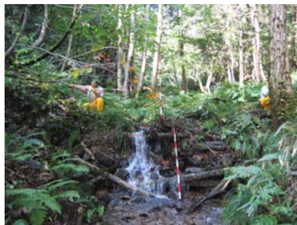
写真-6.1.2.1 現地状況
