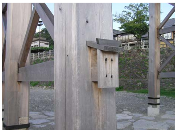
写真-2.2.1 木口からの腐朽に配慮した例 (錦帯橋)
