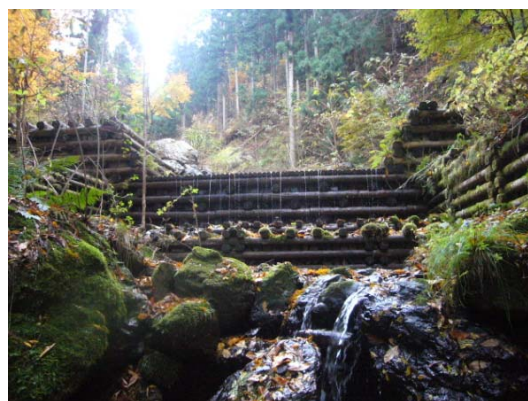
写真-2.3.2 木製治山ダム（京都府京都市）
