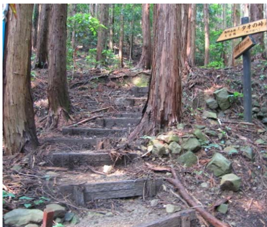
写真-8.4.1 送電線鉄塔巡視路踏み板（熊野古道）
