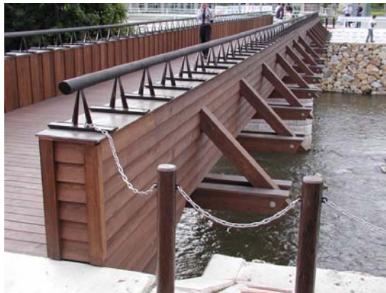
写真-2.2.11 いきいき橋（広島県）
