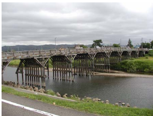
写真-2.2.5 旧来の木橋の例 (旧一新橋／新潟県)
