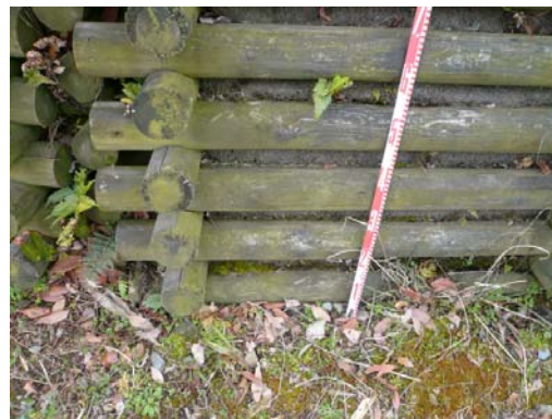
写真-6.3.2.4 校倉式木製土留工 (根来山)
