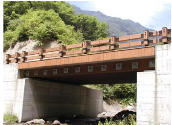
写真-2.2.12 クルワドウ橋（長野県）
