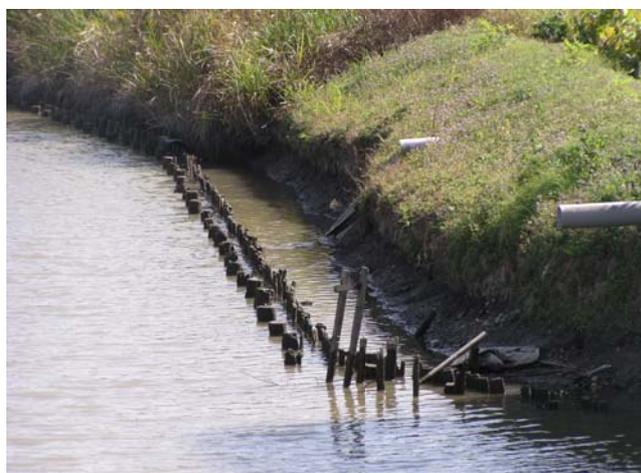
写真-4.8 クリーク崩壊状況
