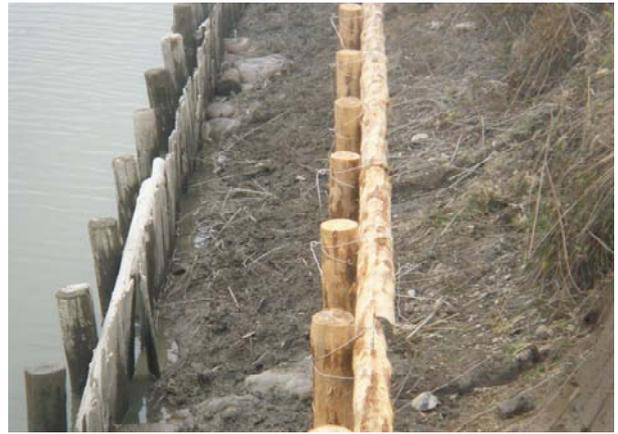
写真-4.10 既設腐朽木柵と新規木柵状況
