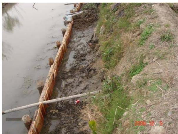
写真-3.1 杭柵工法によるクリーク斜面の改修
