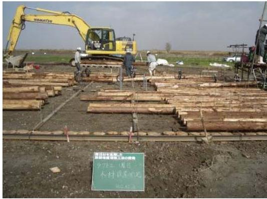
写真-4.16 間伐材の設置
