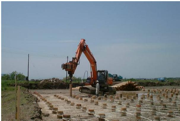
写真-4.1 バックホウによる打込
