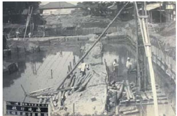
写真-2.14 建設当時の様子（木杭打設）
