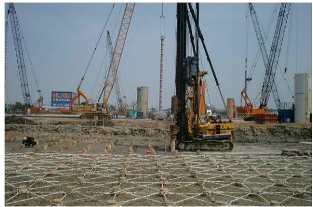
写真-4.2 三点式杭打機による打込
