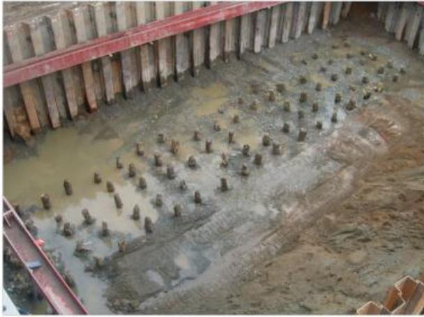
写真-2.3 橋脚を取り除き杭頭部が現れた様子
