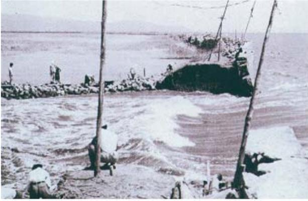
写真-2.17 破堤箇所から激しく流入する海水
