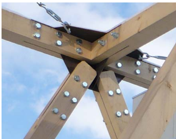
写真-5 橋の格点部
