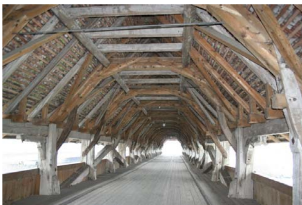
写真－1 大規模補修により部材が交換されている例（ヴァンゲン橋・スイス）
