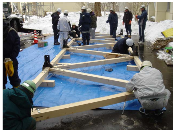
写真-6 組み立ての様子
