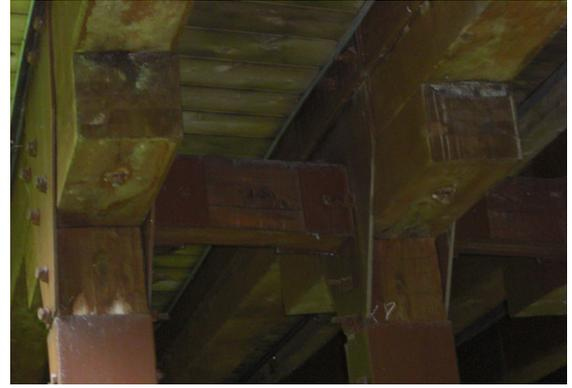
場所 縦梁木口の腐朽
