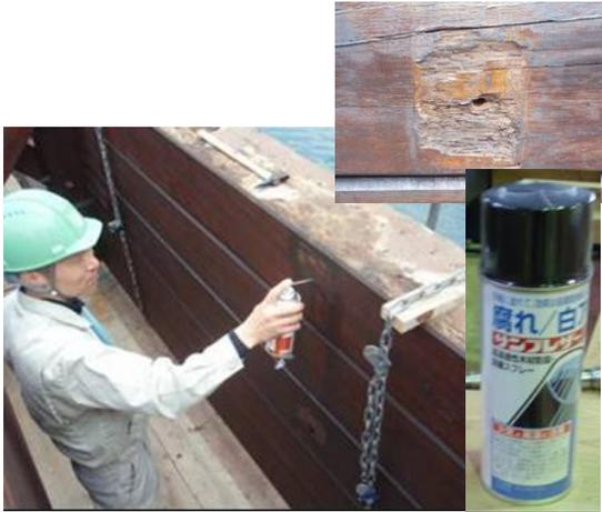
写真-40 ボルト穴に防腐剤を吹きつけしている光景
