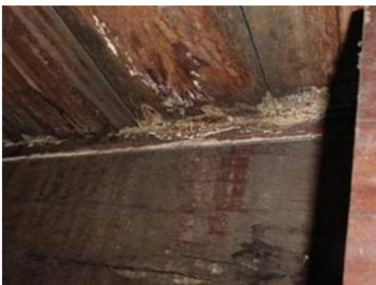
写真-38 床板と主桁の接触部に見られる白色腐朽菌
