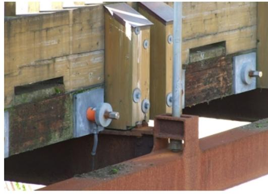
場所 木床版橋端部(ナラ集成材)の腐朽
