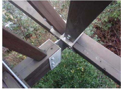
写真-22 CCA加圧注入したヒノキ集成材が使用された木橋
