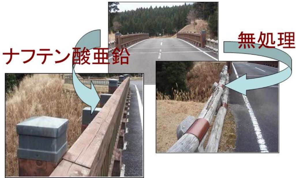
(左) 木橋の防護柵 (ナフテン酸亜鉛を加圧注入したスギ集成材を利用)
