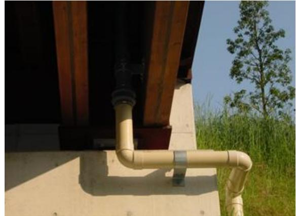
写真-43 雨樋を設け路面の水はけを考慮した事例
