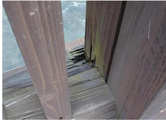
場所 | トラス下弦材、縦材 腐朽箇所
