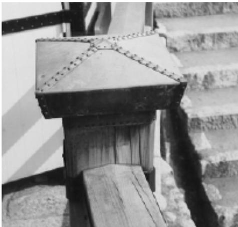
写真-26 高欄支柱に金属カバーを取り付けた木橋
