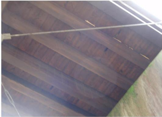
場所 | 床下部 縦桁の腐朽
