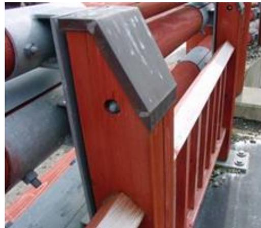
写真-27 金属カバーを取り付けた防護柵の支柱
