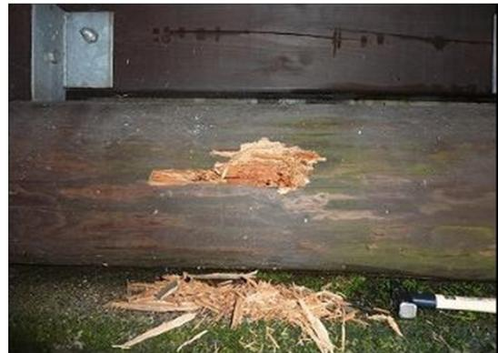
場所 | 枕梁(アカマツ太鼓落とし)の腐朽
