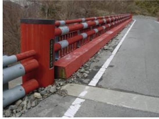
写真-31 金属カバーを付けた親柱 (防護柵にはスギ丸太を使用)
