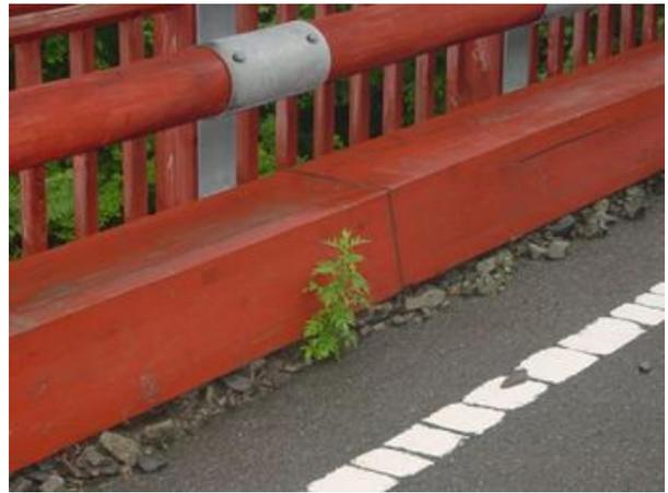
写真-41 地覆を路面から浮かした事例
