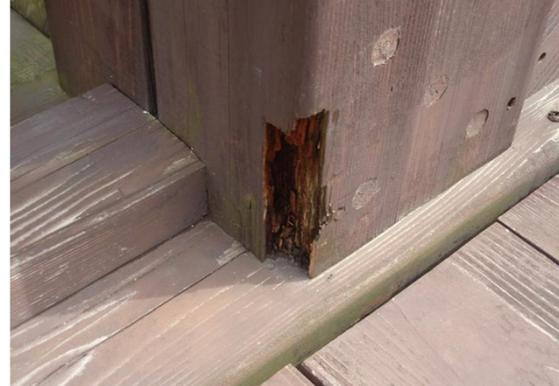
場所 | トラス縦材 腐朽
