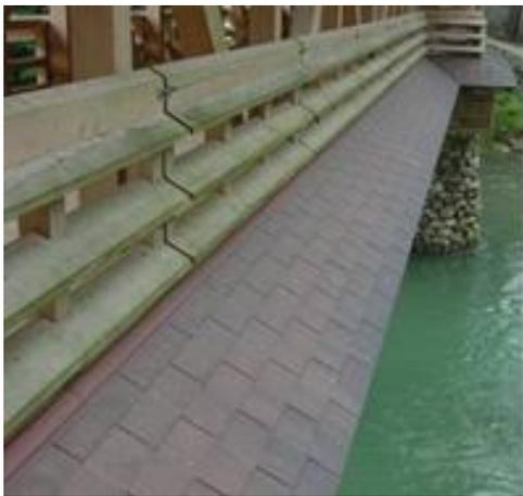
写真-34 下弦材に庇が取り付けられた屋根付きトラス橋
