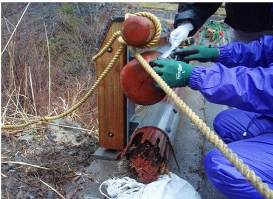
場所 道路防護柵端部の腐朽
