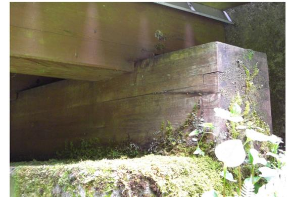
場所 枕梁の腐朽
