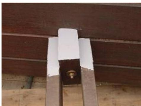
写真-28 対傾構の木口をウレタン塗料で湿布した事例
