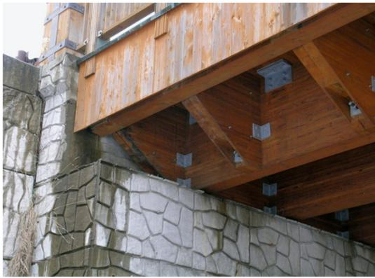
場所 橋梁側面の塗装の経年変化 (2006.01)
