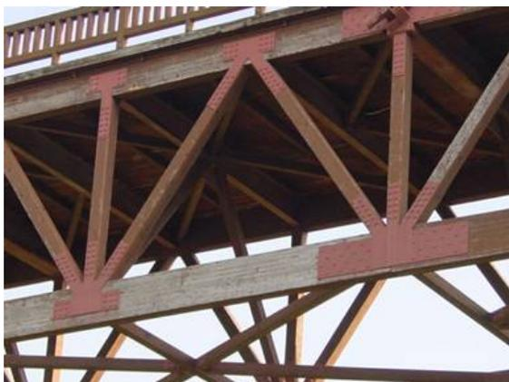
写真-20 PCP(インサイジング処理)を注入したベイマツ集成材が使用された木橋
