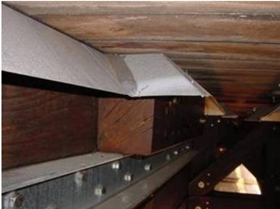
写真-42 主桁に金属カバーを取り付けた事例
