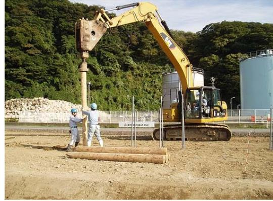
写真-11 地中カーボンストック技術によるCO<sub>2</sub>削減効果の確認試験
