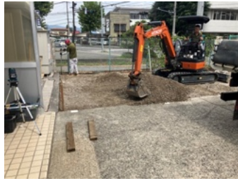
③砕石敷き均し
