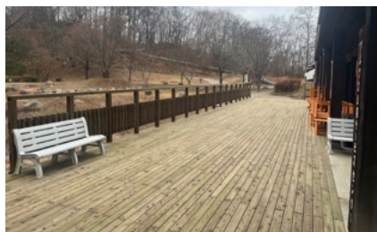
施工事例 デッキ・木道
