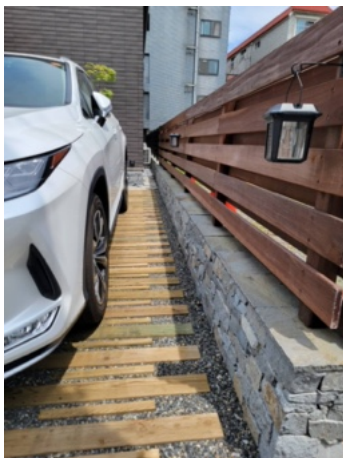
施工事例 戸建て住宅
