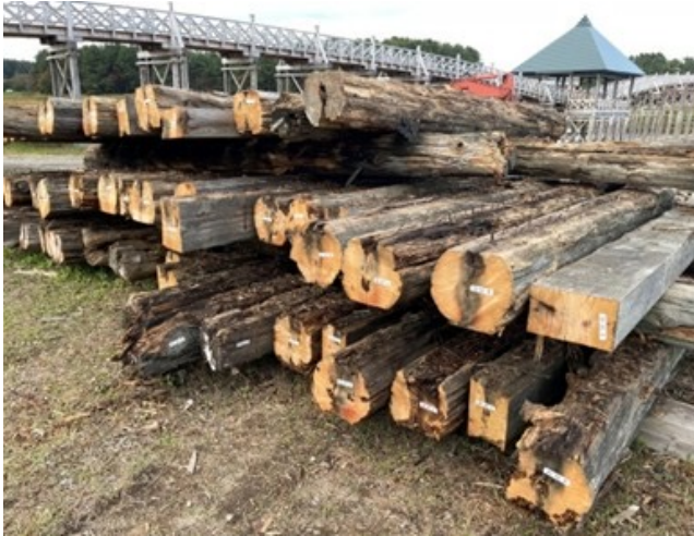
解体された主桁部材
