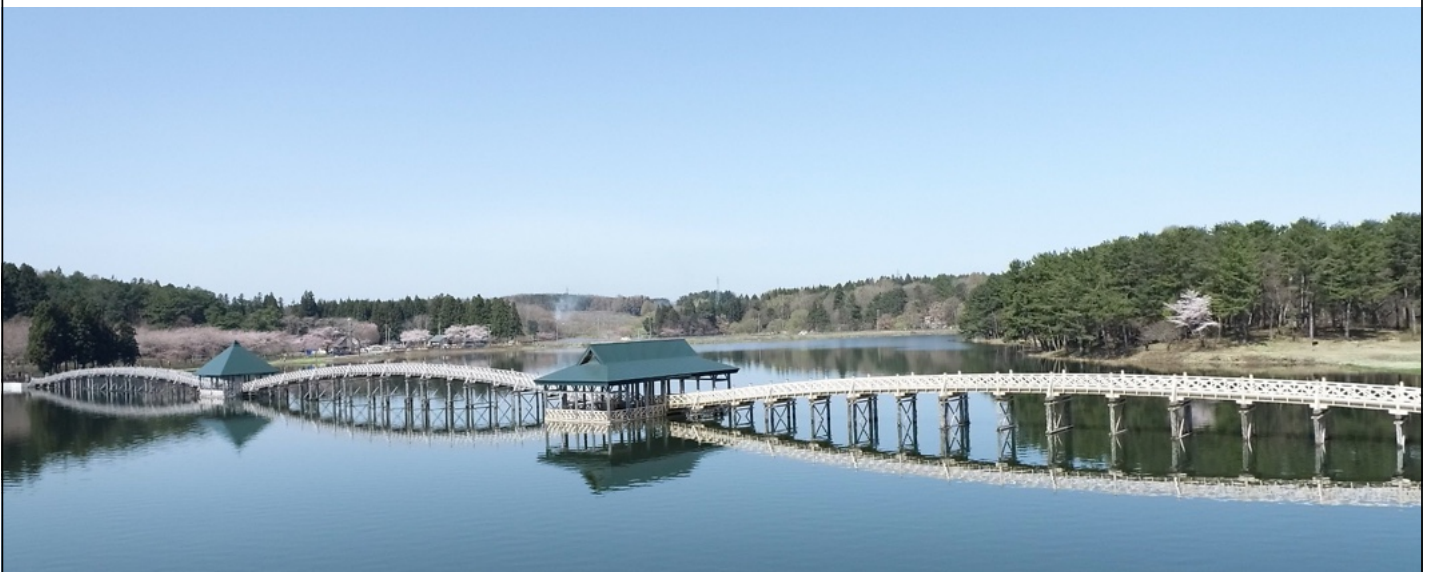
改修後の鶴の舞橋
