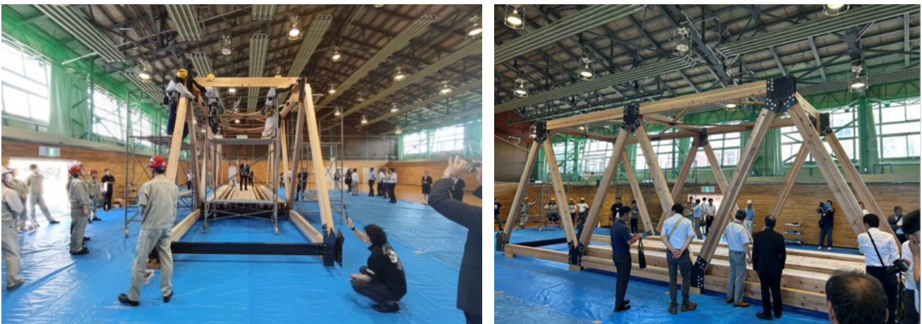
屋内架設実験の様子
