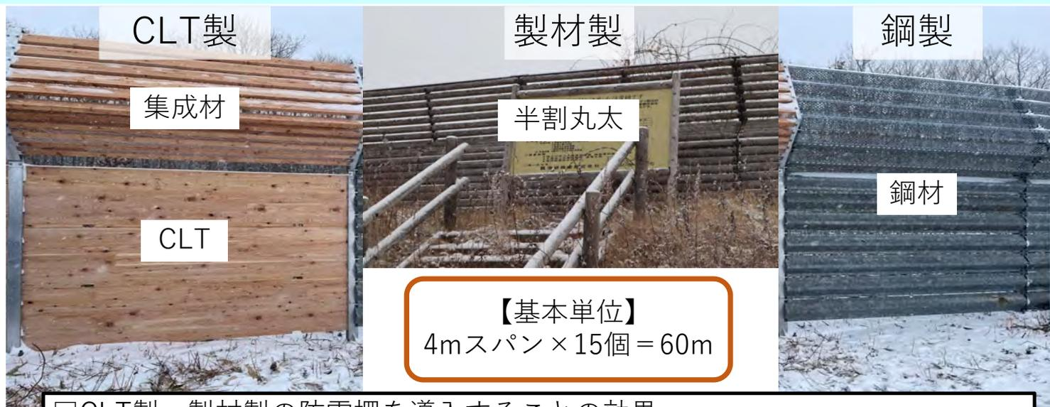
□CLT製・製材製の防雪柵を導入することの効果
