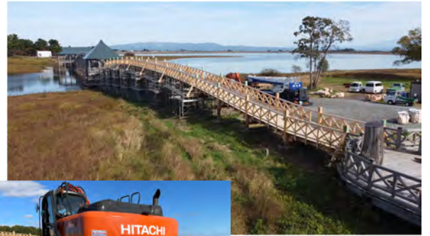
改修工事 (R5~) と撤去材の健全度 調査
