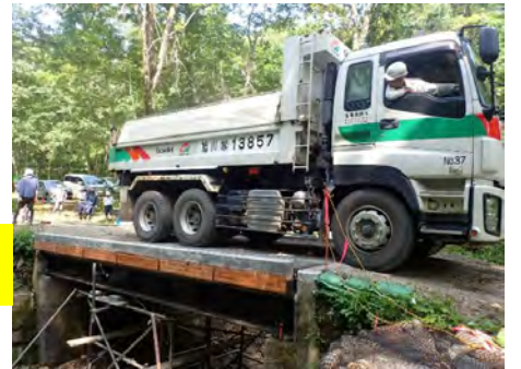
車両載荷試験による検証（2023年）
