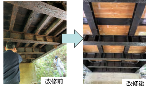
改修前 改修後 1980年建設の道有林の橋梁での実証施工（2022年）
