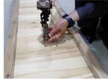
木釘接着の様子
