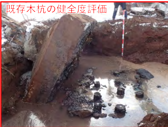
サウンディングによる木杭近傍の強度(密度)変化の分析
