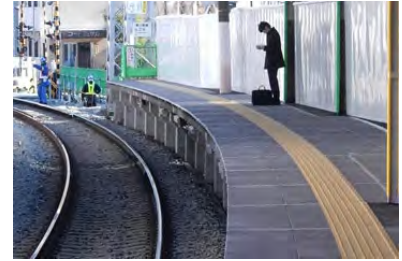
③コネクションデッキ(仮設向け) = 高性能連結式覆工版
