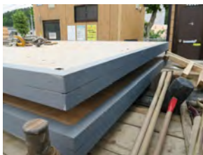
端部補強 (本年度実施)
