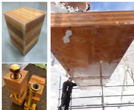
写真2 ■ 歩道橋の設計、施工の現場、木材の積み重ね、接着剤の塗布、接着剤の硬化（メンテナンスが容易で、更新の必要がなかった）写真3 ■ 歩道橋の完成（歩道橋の完成）
