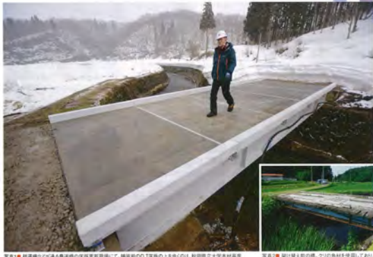
写真1 ■ 経年劣化による橋梁床版の劣化を調査するために、橋梁のCLT床版の上を歩くのは、秋田県立大学木材高度加工研究所の佐々木重隆氏、福島県にある林業系もCLTで高規格の歩道橋（写真2）以外には本誌）
