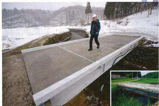
写真1 ■ 駐車場などを構成する道路橋の床版更新実験にて、橋梁のOJT床版の上を歩く人。秋田県立土木材料高度加工工場所の佐々木貴吾教授、監修の両側にある地盤木もじり(写真次ページまで特記以外は本誌)。
