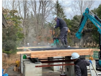
アスファルト舗装作業
