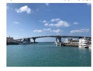
受賞理由:沖縄の物流基幹道路である那覇港臨海道路の泊大橋における経年劣化 と損傷を受けた支承取替に際し、長期にわたるジャッキアップ中の監視体制を構 築することで一般交通を供用しながらの施工を完遂するとともに、新支承へ防食 塗装を適用することで耐久性向上を実現した。
