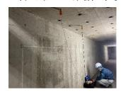
受賞理由:完全非破壊でコンクリート中の鉄筋腐食の状態を高精度で測定する方法・機器を開発したことで、維持管理にかかる生産性向上、作業環境改善による働き方改革に貢献した。さらには、劣化状況の詳細把握により補修範囲を過不足なく設定することで補修費用低減にも寄与する。
