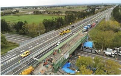
(受賞理由) 道央自動車道江別東 IC 橋の中空床版全面打換え工事において、コリジョンジェット工法や移動式防護柵を活用し、施工期間短縮を実現した。品質確保・工程管理に向けた各種取り組みにより、社会的影響の最小化を達成した。この取組みは今後計画されている同種工事に広く適用されることが期待される。
