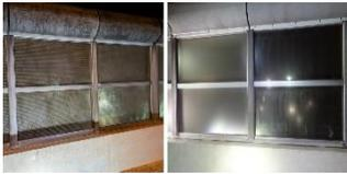
(受賞理由) 劣化すると脆化するポリカーボネート樹脂製透光板は、車両接触により割れて破片が落下すると第三者被害を引き起こす恐れがあったが、脆化した透光板を容易に機能回復させる透明な飛散防止材を開発したことで、工事費削減と工期短縮を図りながら安全な沿道環境を提供することが可能となった。
