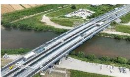
（受賞理由）九州自動車道宝満川橋の床版取替工事において、幅員分割取替工法を採用することで連続規制期間を最小化し、地域交通の大動脈維持に貢献した。今後床版取替を控える多くの更新工事への参考となることが期待される。
