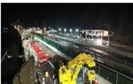
（受賞理由）老朽化等により損傷が進展している名神高速道路の河内橋において床版取替工事を集中工事期に実施。短期間での工事完了により交通負荷を低減し、新設床版には超高強度繊維補強コンクリートを採用して長期耐久性を向上させた。都市部などの交通量が多い区間での工事で懸念される深刻な交通渋滞を低減する一つの方向性を示した。
