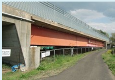
東北自動車道 大森川橋
