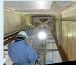
撮影状況 (足場上)
