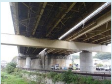
中央自動車道 城山川第二橋
