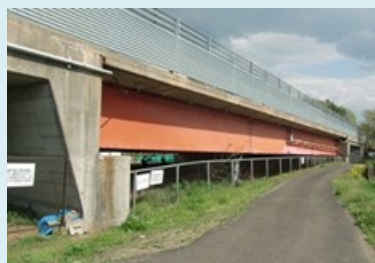
東北自動車道 大森川橋
