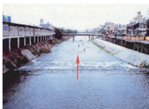
京阪電鉄地下化以前の鴨川
