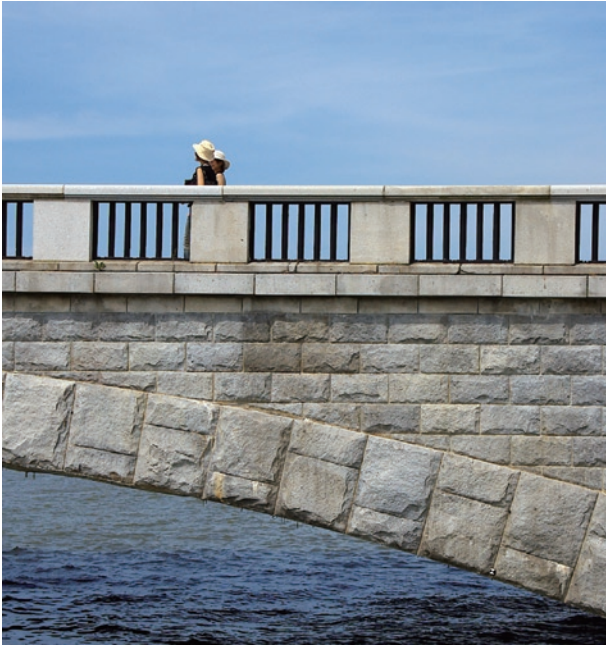
80年経ってますます風格の増した橋側面の石貼
