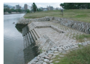
丁寧な石積みによる護岸
