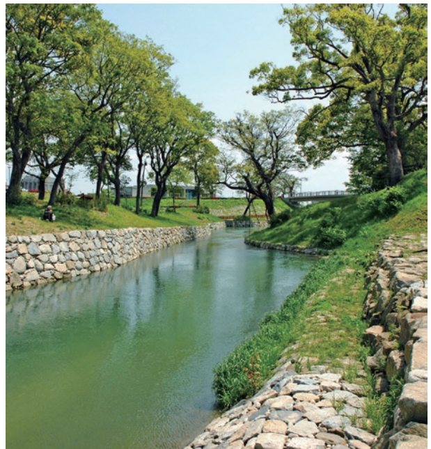
丁寧に積み直された石積護岸によって魅力ある水辺へと変化
