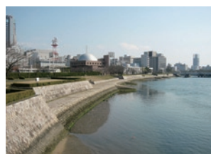
改修後の空鞆橋上流
