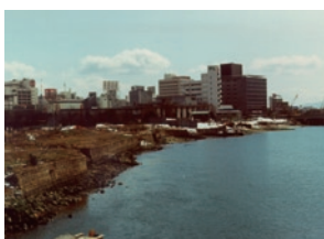
改修前の空鞆橋上流
